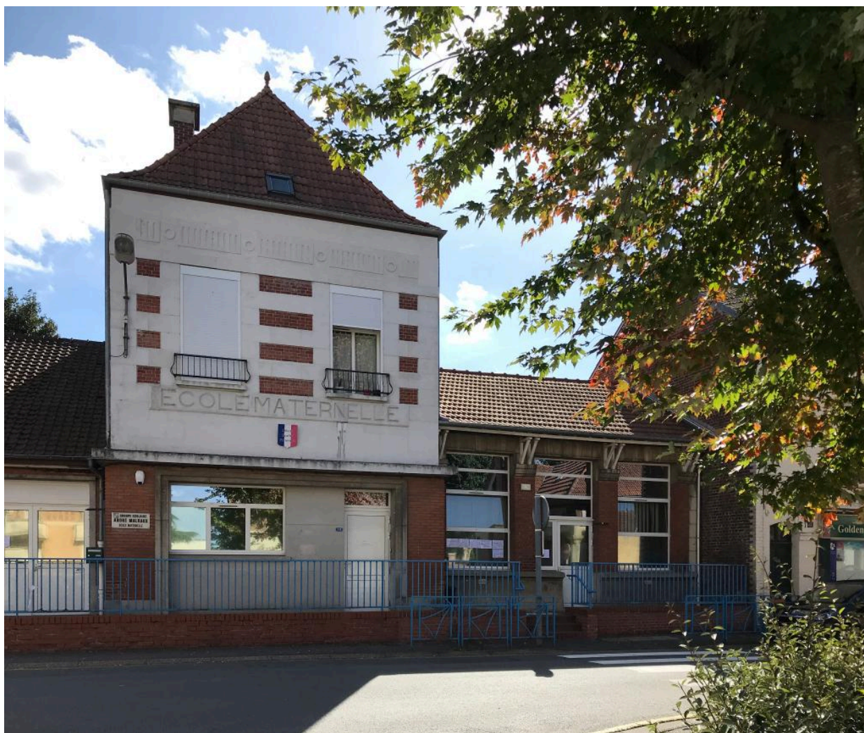
Vue des bâtiments reconstruits après la Première Guerre mondiale.
