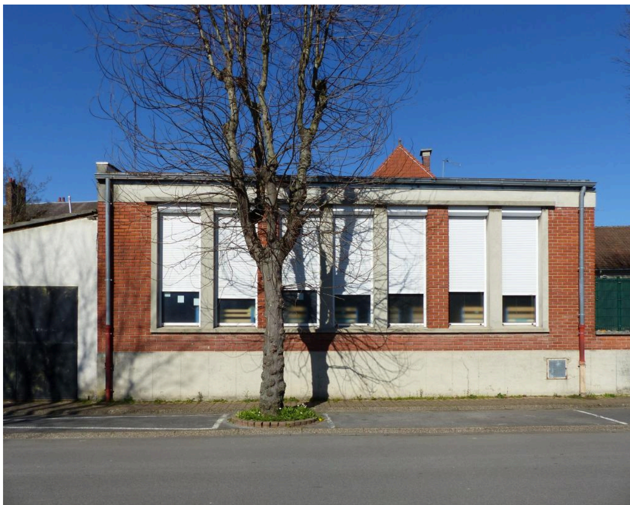
La classe construite au sud.
