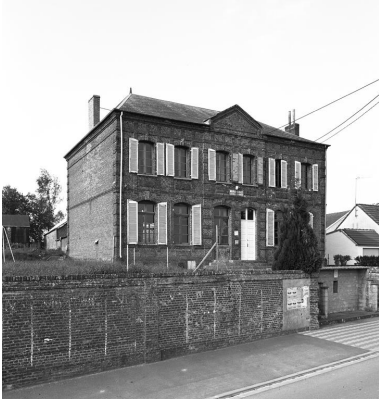
Vue générale. Phot. Thierry Lefébure IVR22_19930200484V
