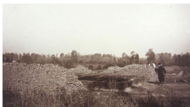
Visite de l'architecte sur le chantier de construction des maisons de contremaîtres, octobre 1920 (AD Somme ; 49 Fi 80).
