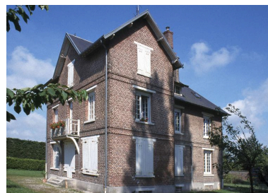
Vue d'ensemble d'un des logements de contremaîtres. Phot. Bertrand Fournier IVR22_20008000420ZA
