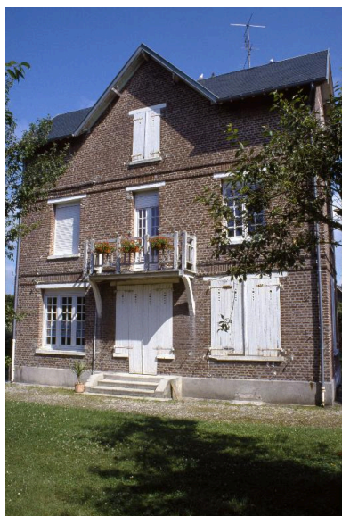
Façade principale d'un des logements, vue de face.
