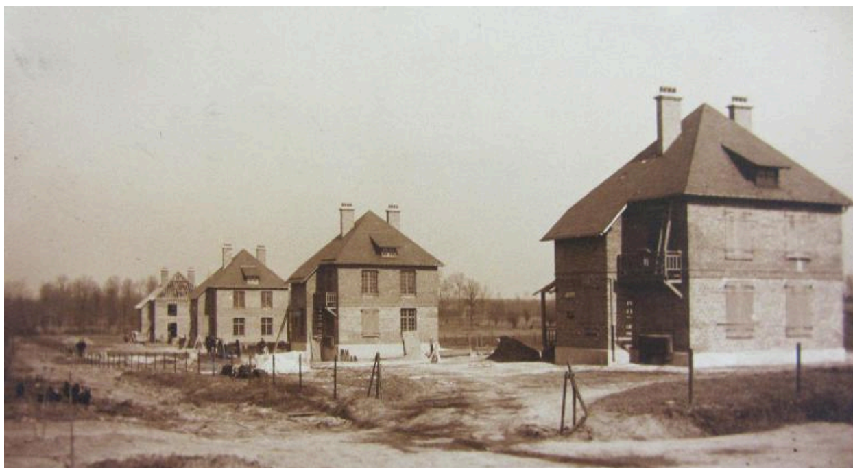
Vue d'ensemble des quatre maisons de contremaître achevées, 14 mars 1921 (AD Somme ; 49 Fi 90).
