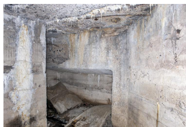
Salle sud et mur de refend, à gauche Phot. Pierre Thibaut
