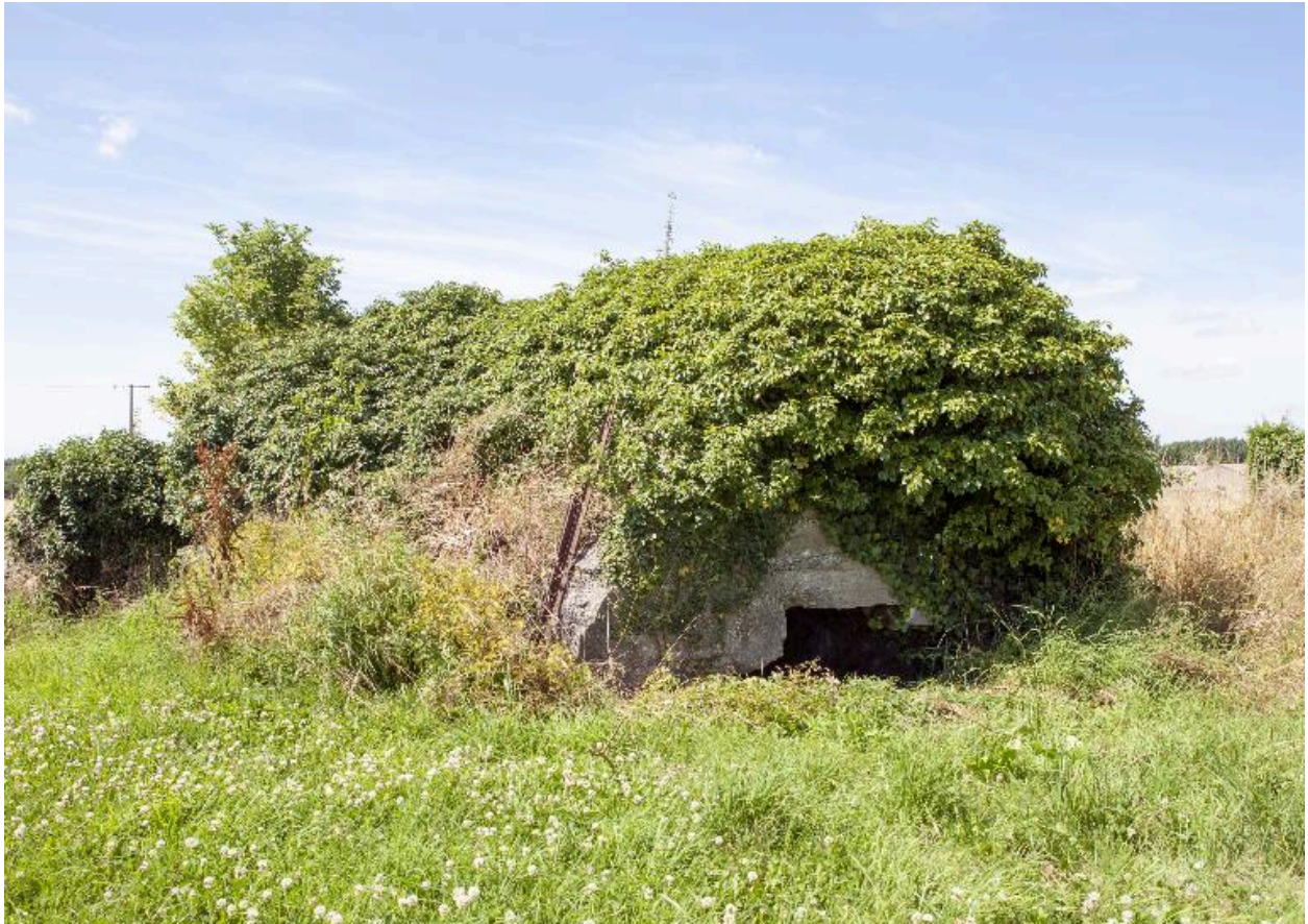
Casemate à munition, vue de trois-quarts vers le nord.
