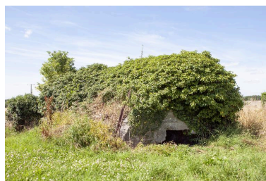
Casemate à munition, vue de trois-quarts vers le nord.
