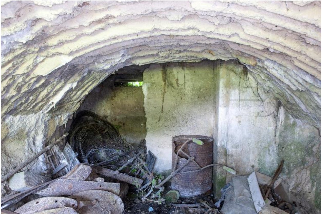
Casemate à munitions, vue intérieure
