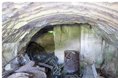
Casemate à munitions, vue intérieure
