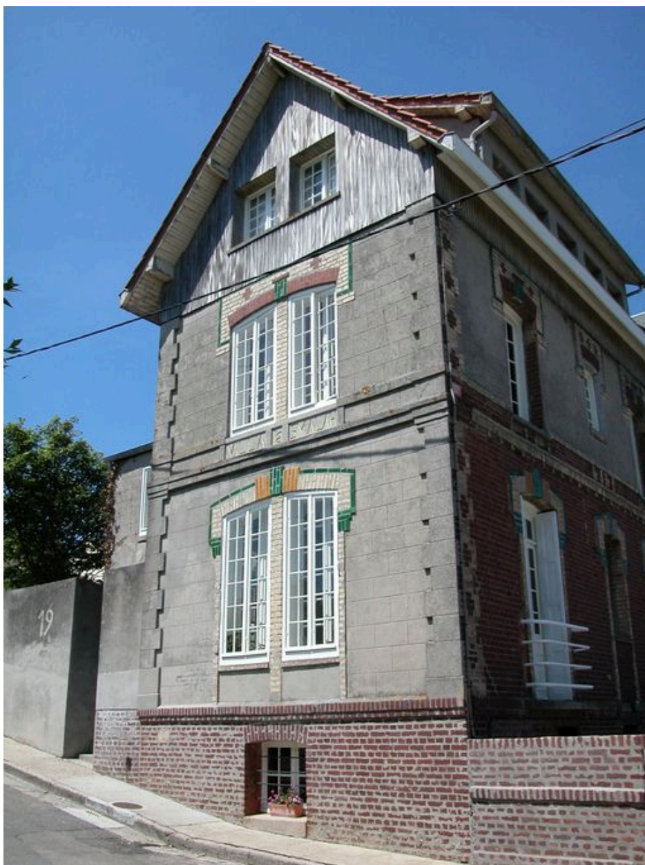
Façade latérale gauche.
