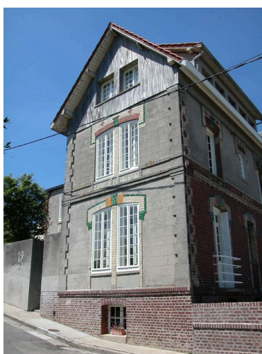
Façade latérale gauche. Phot. Elisabeth Justome IVR22_20058003027NUCA
