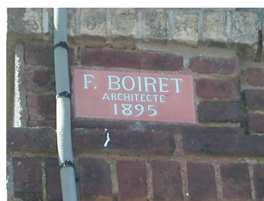
Détail de la signature en façade. Phot. Elisabeth Justome IVR22_20058003028NUCA
