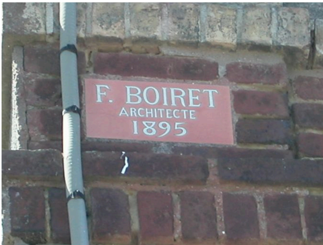
Détail de la signature en façade.
