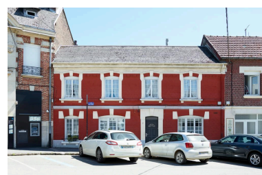
Vue générale de la maison du gardien depuis la place Sadi-Carnot. Phot. Delphine Volto-Jourdan IVR32_20216200636NUCA
