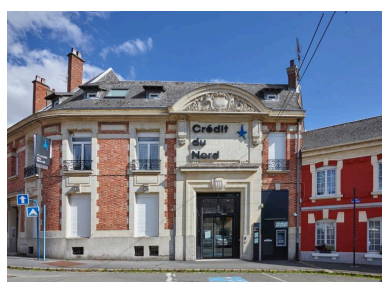
Vue générale de la banque depuis la place Sadi-Carnot. Phot. Hubert Bouvet IVR32_20196200677NUC4A
