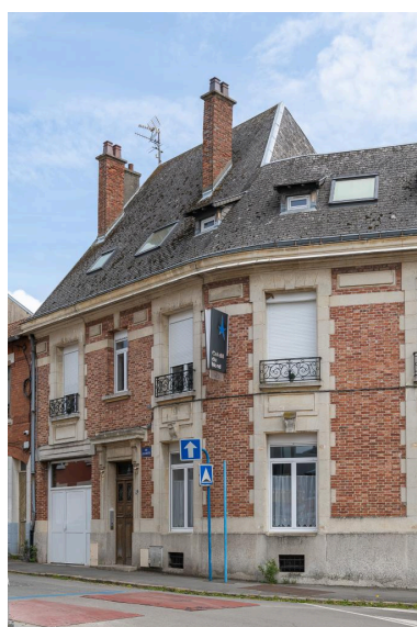
Façade de la maison du directeur et première travée de la façade de la banque depuis la place Sadi-Carnot. Phot. Marc Kérignard IVR32_20226200035NUCA
