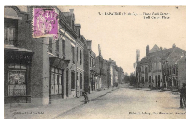
7 - bapaume, (P.-de-C.) - Place Sadi Carnot, the Sadi Carnot Place. Edition Hôtel Sheffield, cliché R. Lelong, rue Miramont, Amiens. Carte postale, vers 1930 (coll. part.). La banque Crédit du Nord est visible au fond à droite Phot. Thibaut Pierre (reproduction) IVR32_20206200020NUCA
