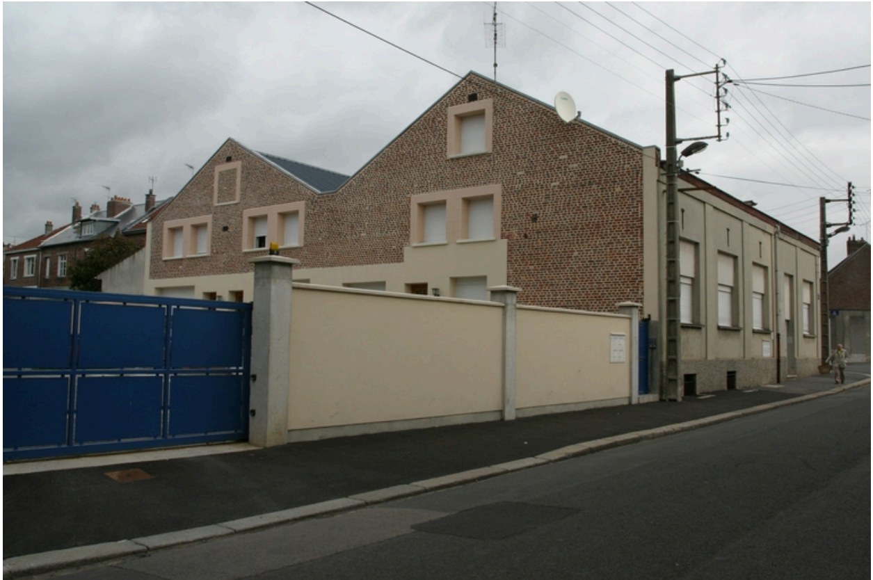
Façade postérieure des ateliers (pignons sud-ouest).
