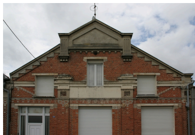
Détail de la façade antérieure des ateliers. Phot. Frédéric Pillet IVR22_20040200715NUCA
