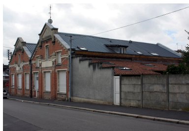
Façade antérieure des ateliers (pignons nord-est). Phot. Frédéric Pillet IVR22_20040200712NUCA
