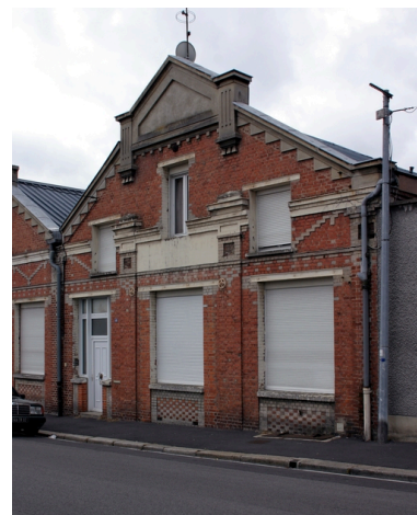
Détail de la façade antérieure des ateliers. Phot. Frédéric Pillet IVR22_20040200714NUCA
