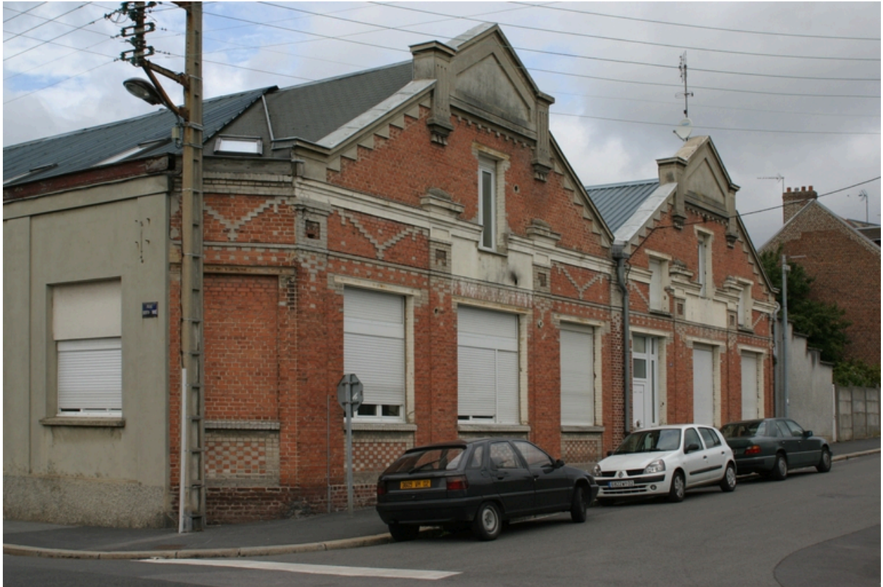
Façade antérieure des ateliers (pignons nord-est).
