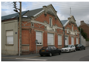
Façade antérieure des ateliers (pignons nord-est). Phot. Frédéric Pillet IVR22_20040200713NUCA
