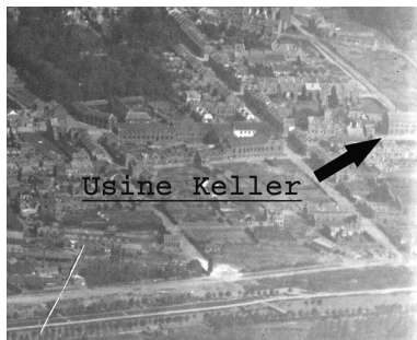
Vue aérienne de l'usine le 25 mai 1917, avant sa destruction totale (Société Académique de Saint-Quentin). Phot. Pillet Frédéric IVR22_20040200618NUCAB
