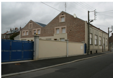
Façade postérieure des ateliers (pignons sud-ouest). Phot. Frédéric Pillet IVR22_20040200716NUCA
