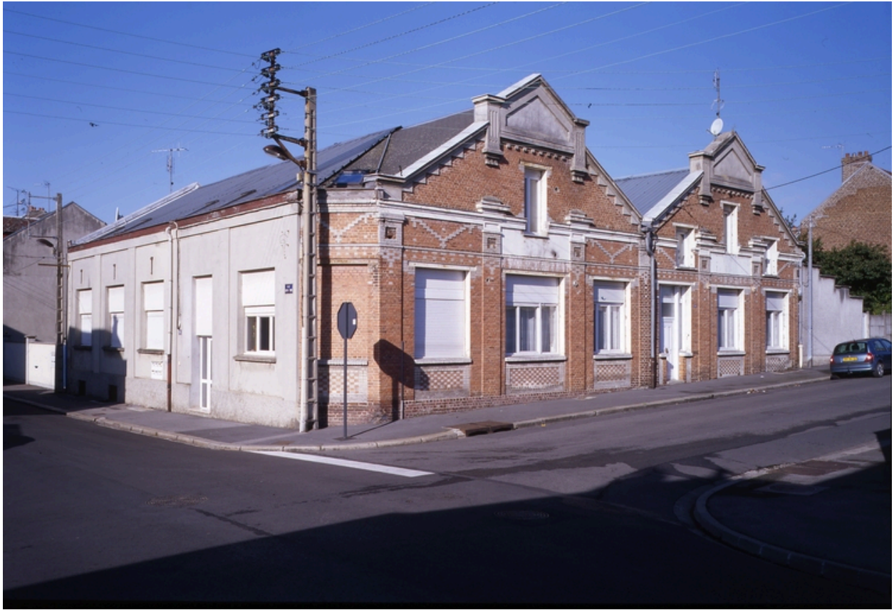
Les ateliers vus depuis le carrefour des rues Pierre-Ramus et Quentin-Barré.
