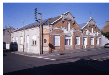
Les ateliers vus depuis le carrefour des rues Pierre-Ramus et Quentin-Barré. Phot. Thierry Lefebure IVR22_20070200049XA
