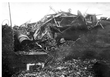
Les ruines de l'usine photographiées en 1919 (AD Aisne). Phot. Pillet Frédéric IVR22_20040200620NUCAB
