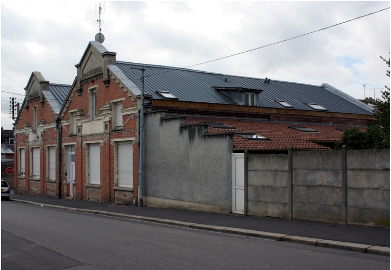
Façade antérieure des ateliers (pignons nord-est).
