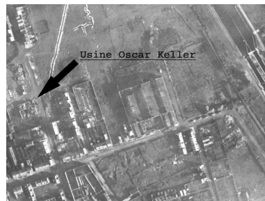
Vue aérienne de l'usine en novembre 1918, après destruction (AD Aisne). Phot. Pillet Frédéric IVR22_20040200619NUCAB
