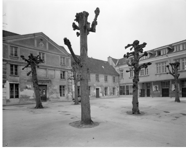
Les bâtiments vus de l'intérieur de la cour. Phot. Patrick Glotain IVR22_19930200519V
