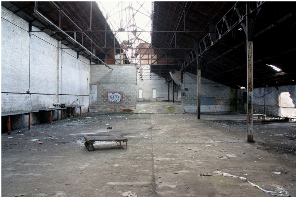
Vue intérieure du magasin industriel.
