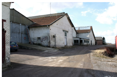
Les ateliers, le magasin industriel (faîtage vitré) et un entrepôt (au fond). Phot. Frédéric Pillet IVR22_20060205137NUCA
