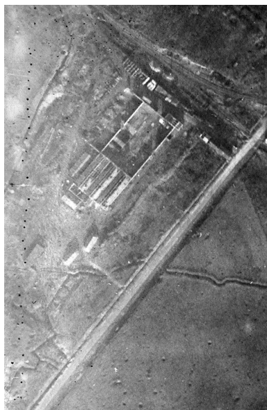
Vue aérienne, novembre 1911 (AD Aisne). Phot. Pillet Frédéric IVR22_20050206626NUCAB
