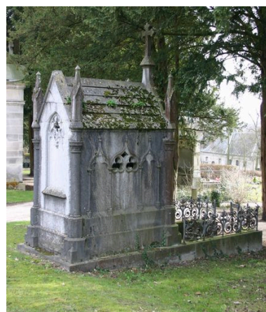
Vue générale (face postérieure).
