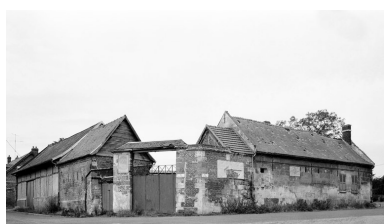
Ferme repérée, élévations sur rue de l'Eglise et rue de la Mairie. Phot. Jean-Michel Périn IVR22_19846000968X
