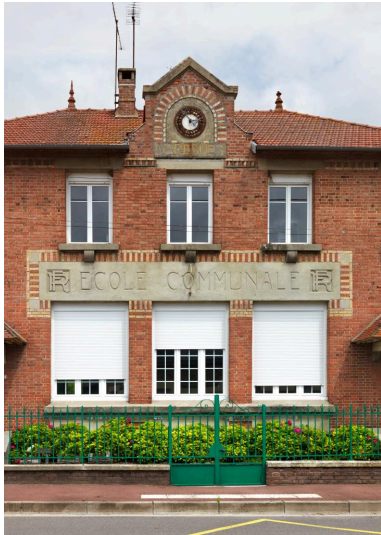
Vue des travées centrales. Phot. Thierry Lefébure IVR32_20216000797NUCA
