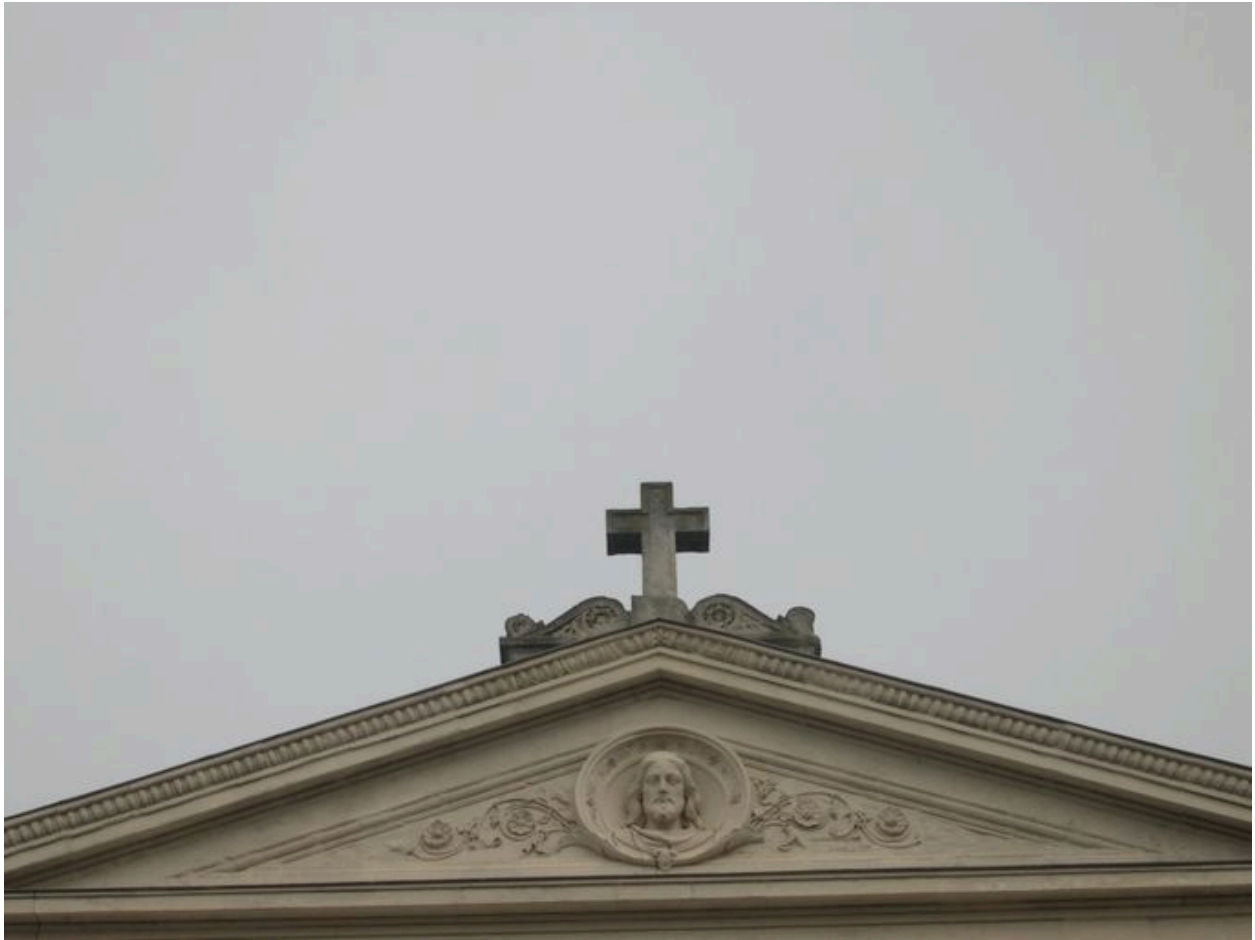
Vue de détail : fronton du couronnement.
