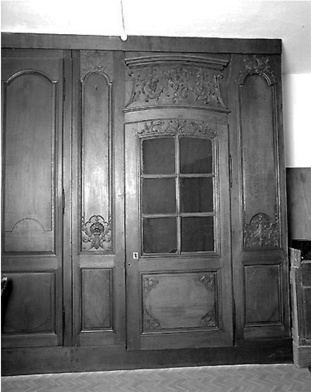
Sacristie : partie droite des lambris de revêtement.
