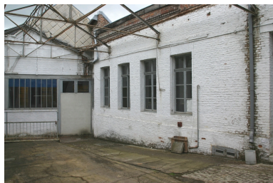
A droite une partie des ateliers de 1861, à gauche les ateliers de 1900. Phot. Frédéric Pillet IVR22_20050205542NUCA
