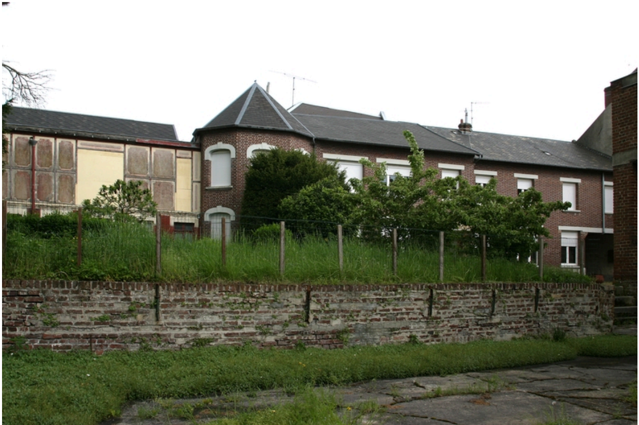
Logement patronal : façade antérieure.
