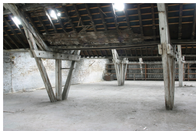
Combles de l'atelier de 1900 : ancien atelier de préparation en 1914.
