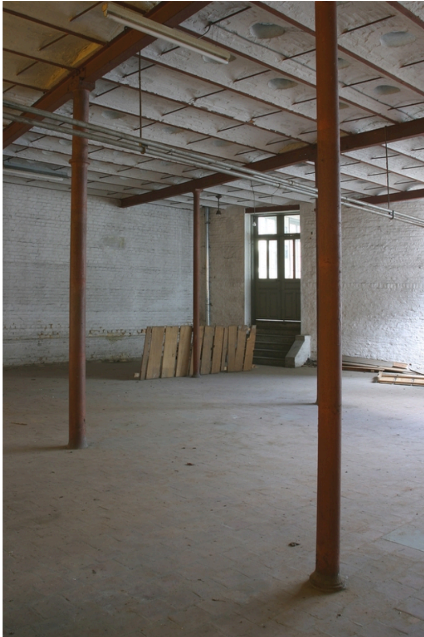
Rez-de-chaussée de l'atelier de 1900.
