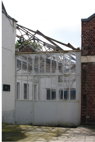
Porte métallique percée après 1914 à l'emplacement d'une partie des ateliers de 1861, et donnant accès à la cour couverte. Phot. Frédéric Pillet IVR22_20050205540NUCA
