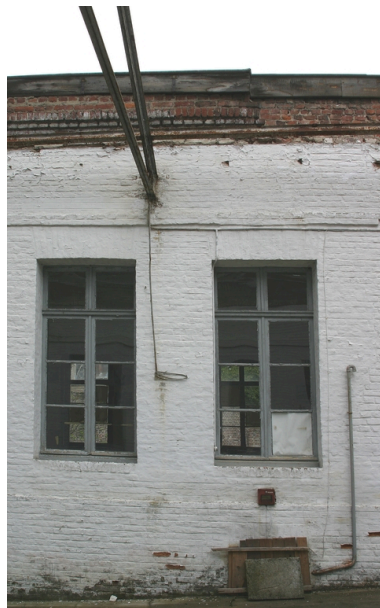
Détail de deux travées de la façade sur cour des ateliers de 1861. Phot. Frédéric Pillet IVR22_20050205543NUCA
