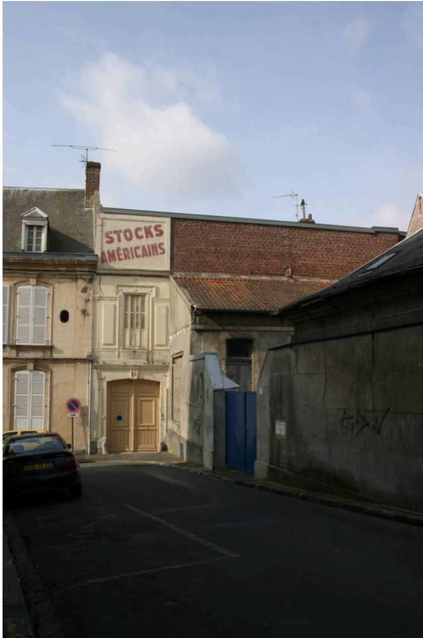
La porte cochère constituant la façade sur rue.
