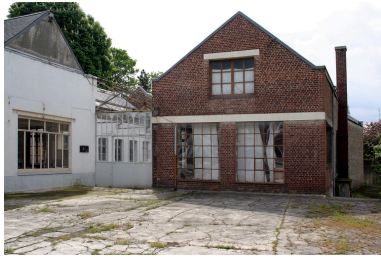
Les ateliers de 1861 formant un L, et scindés en deux entités après 1914. Les deux pignons révèlent bien les démolitions opérées. Phot. Frédéric Pillet IVR22_20050205545NUCA
