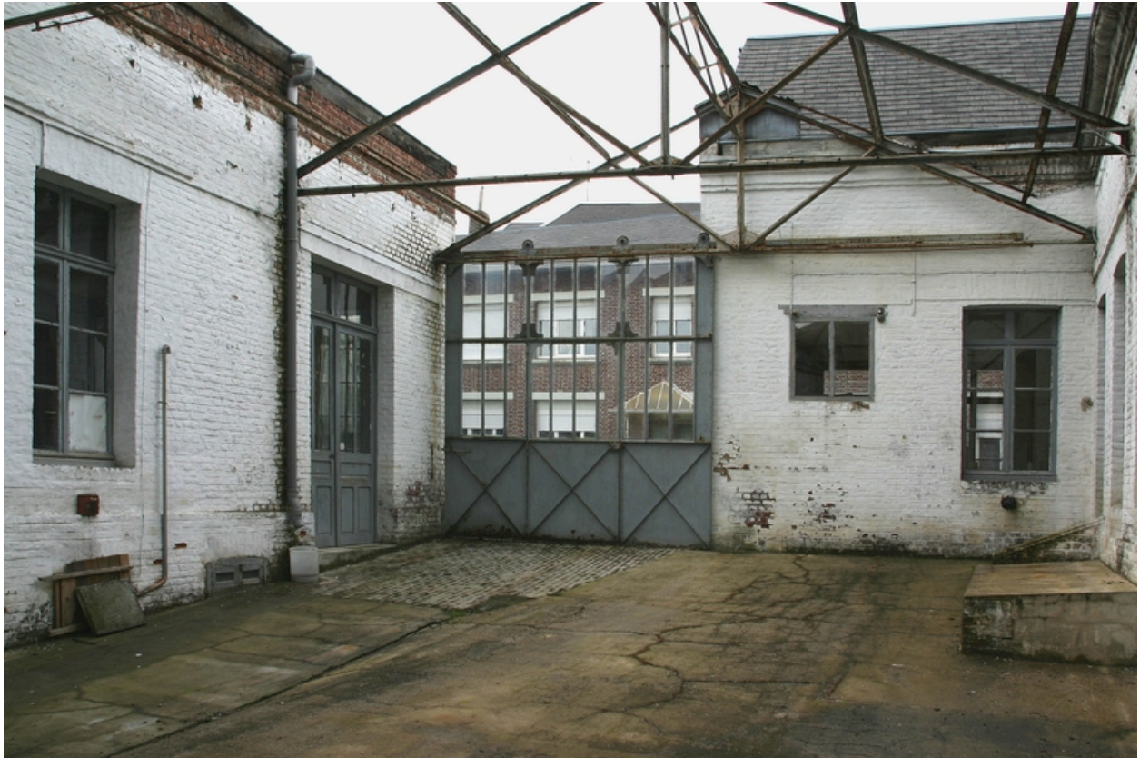
Les ateliers de 1861 formant initialement un L, et dont l'angle est démoli après 1914.
