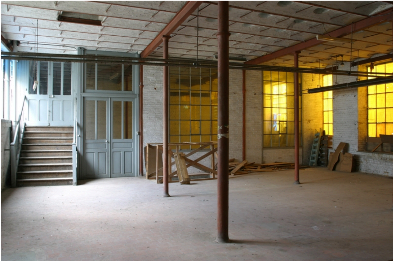
Rez-de-chaussée de l'atelier de 1900.
