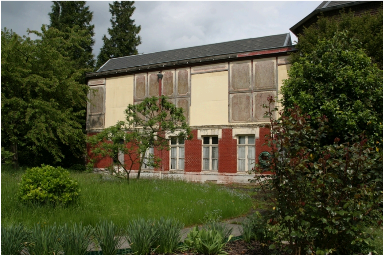
Façade antérieure du logement patronal : cuisine et buanderie (rez-de-chaussée), bibliothèque et studio, en 1914.
