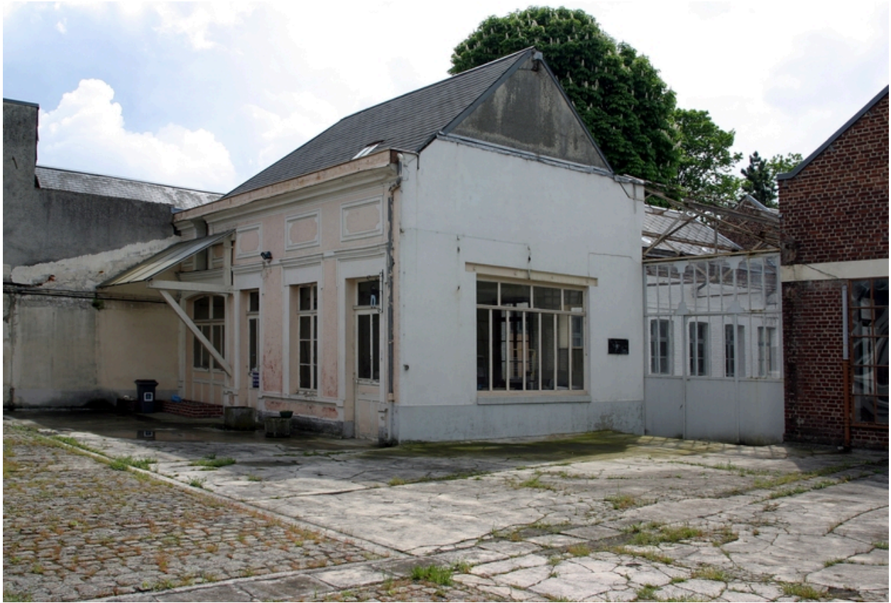
Façade antérieure des ateliers de 1861 : la démolition partielle de ceux-ci est parfaitement lisible.
