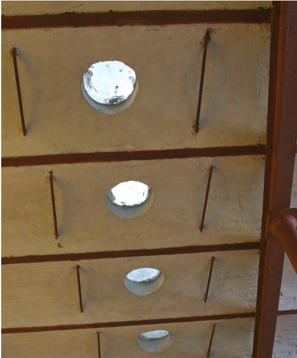
Voûtains du plancher des combles de l'atelier de 1900, percés de pavés de verre pour l'éclairage du rez-de-chaussée.
