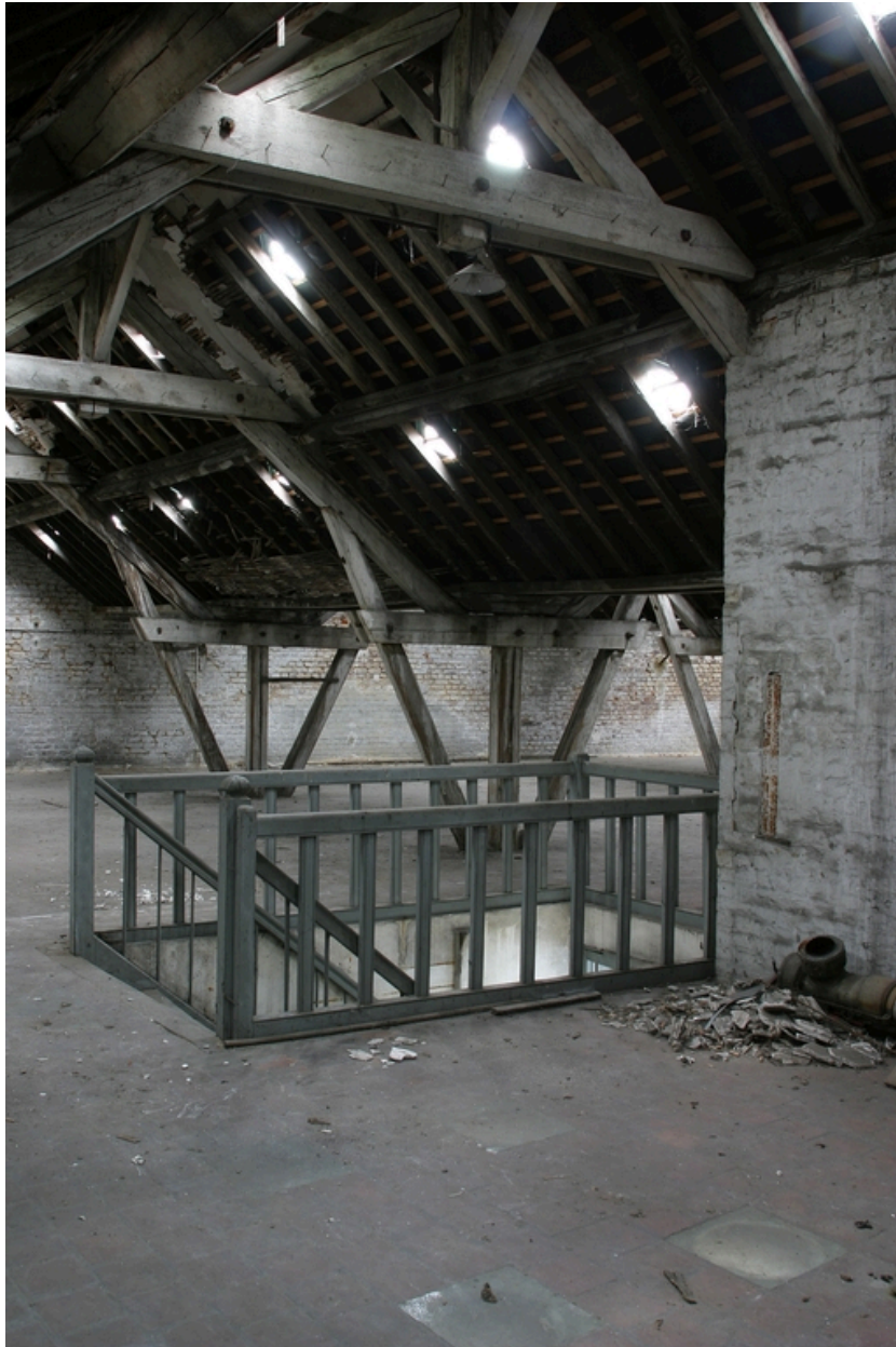
Combles de l'atelier de 1900 : ancien atelier de préparation en 1914.
