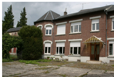
Façade antérieure du logement patronal. Phot. Frédéric Pillet IVR22_20050205564NUCA
