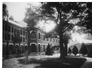
Le logement patronal photographié dans les années 1920-1930 (AP). Phot. Pillet Frédéric IVR22_20050205529NUCAB
