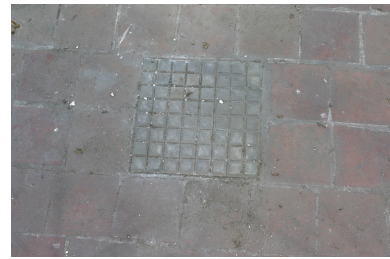
Pavé de verre du plancher des combles de l'atelier de 1900, pour l'éclairage du rez-de-chaussée.
