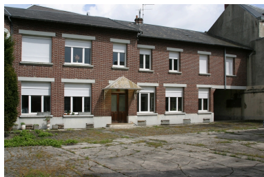
Façade antérieure du logement patronal : à droite, le porche donnant accès à la rue Etienne-Dolet. Phot. Frédéric Pillet IVR22_20050205563NUCA
