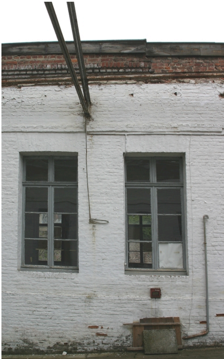
Détail de deux travées de la façade sur cour des ateliers de 1861.
