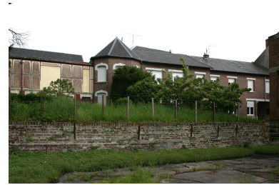
Logement patronal : façade antérieure. Phot. Frédéric Pillet IVR22_20050205562NUCA
