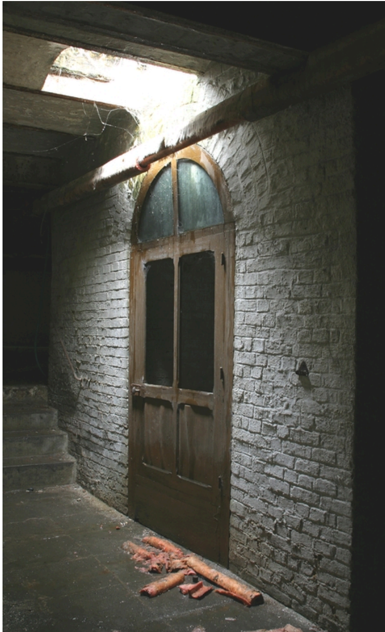
Ancienne chaufferie de l'usine : petite pièce voûtée en cul-de-four (ancien puits ?).
