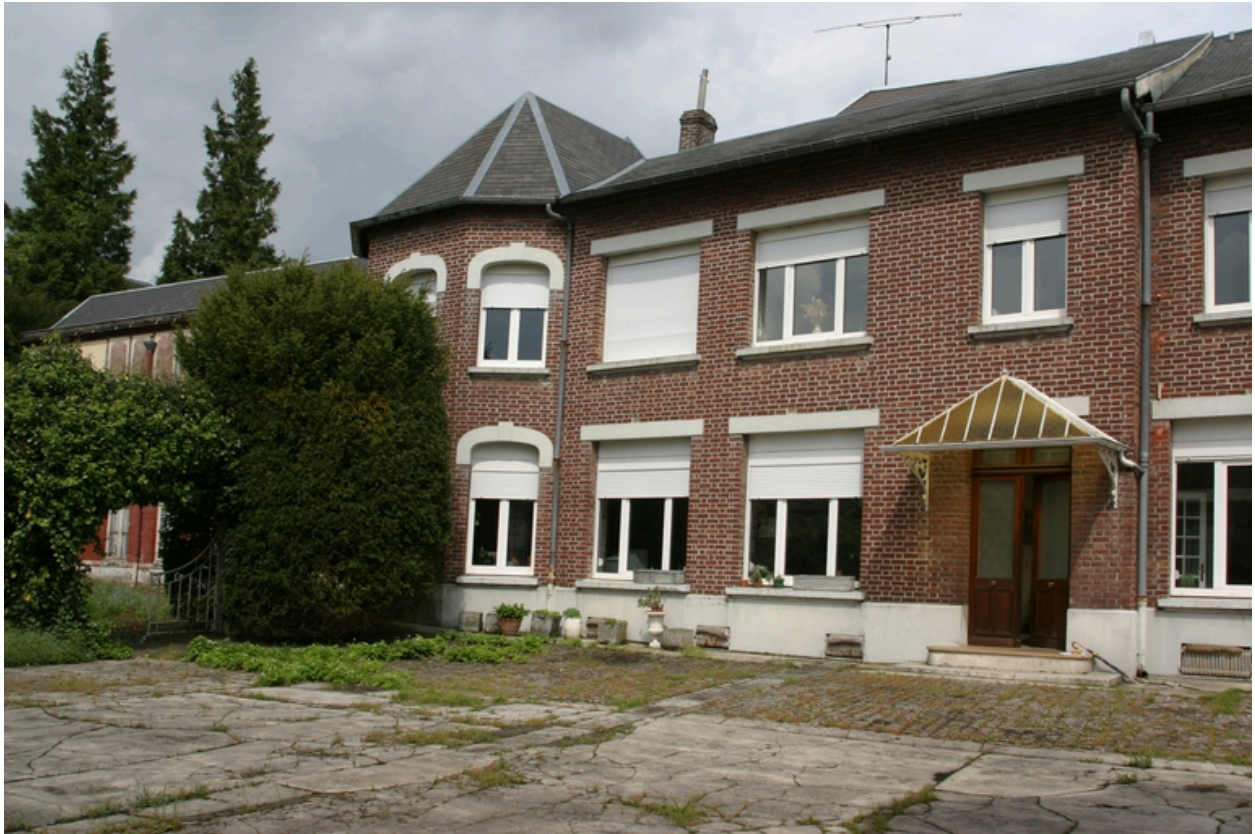
Façade antérieure du logement patronal.
