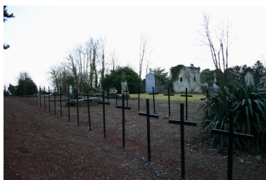
Vue générale, vers l'est. Phot. Caroline Vincent IVR22_20088000904NUCA
