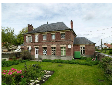
Vue de l'élévation sud et du jardin. Phot. Thierry Lefébure IVR22_20138000242NUC2A
