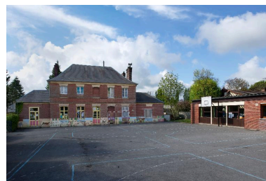
Vue générale depuis la cour de récréation, au nord. Phot. Thierry Lefébure IVR22_20138000241NUC2A
