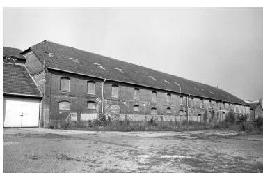
Vue longitudinale du mur ouest du four industriel construit en 1907. Phot. Laurent Jumel IVR22_19966002568X
