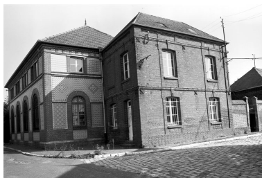
Mur sud du bureau. Phot. Laurent Jumel IVR22_19966002575X
