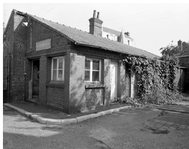
La conciergerie, côté sud. Phot. Laurent Jumel IVR22_19966002578X
