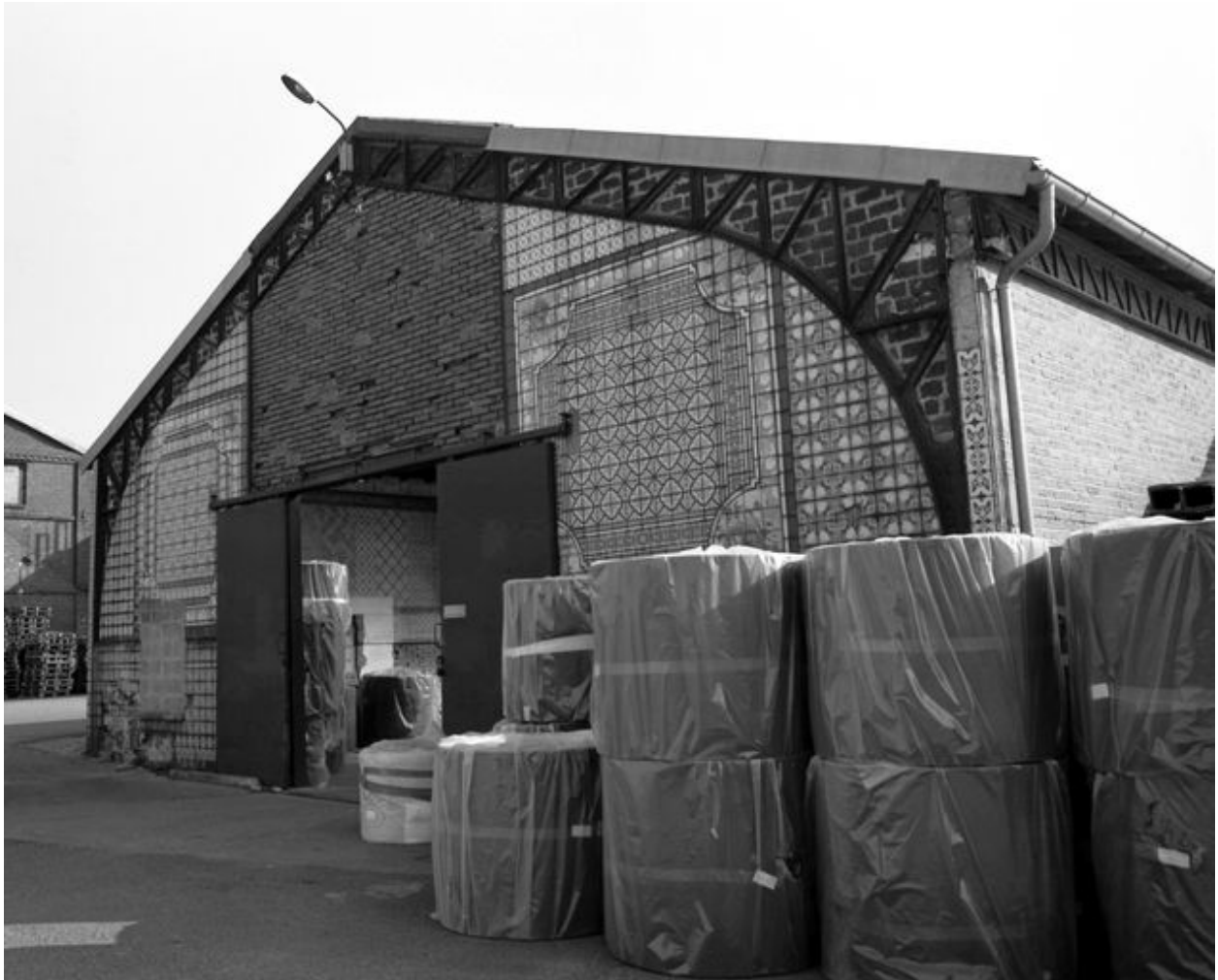
Le magasin industriel, pignon ouest.
