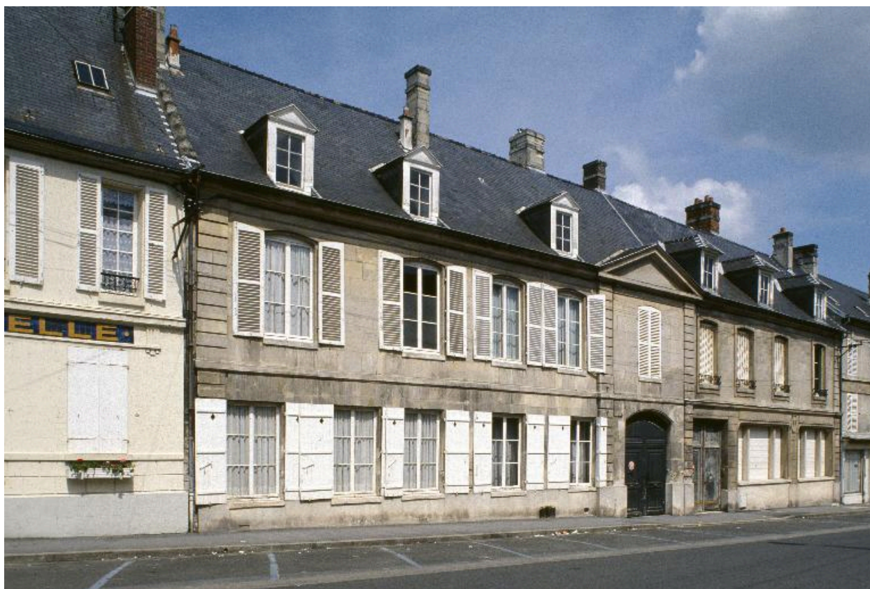
La façade de l'ancienne vénerie, vue de trois quarts.
