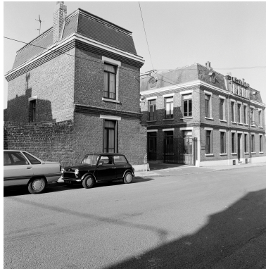
Bureaux, élévation antérieure. Phot. Olivier Marlard IVR31_19905901055X
