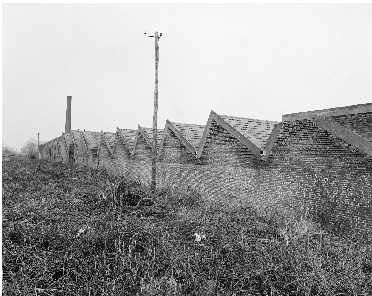
Atelier de fabrication, élévation postérieure.
