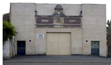
Façade sur rue du magasin industriel. Phot. Thierry Lefébure IVR22_20046000242NUCA
