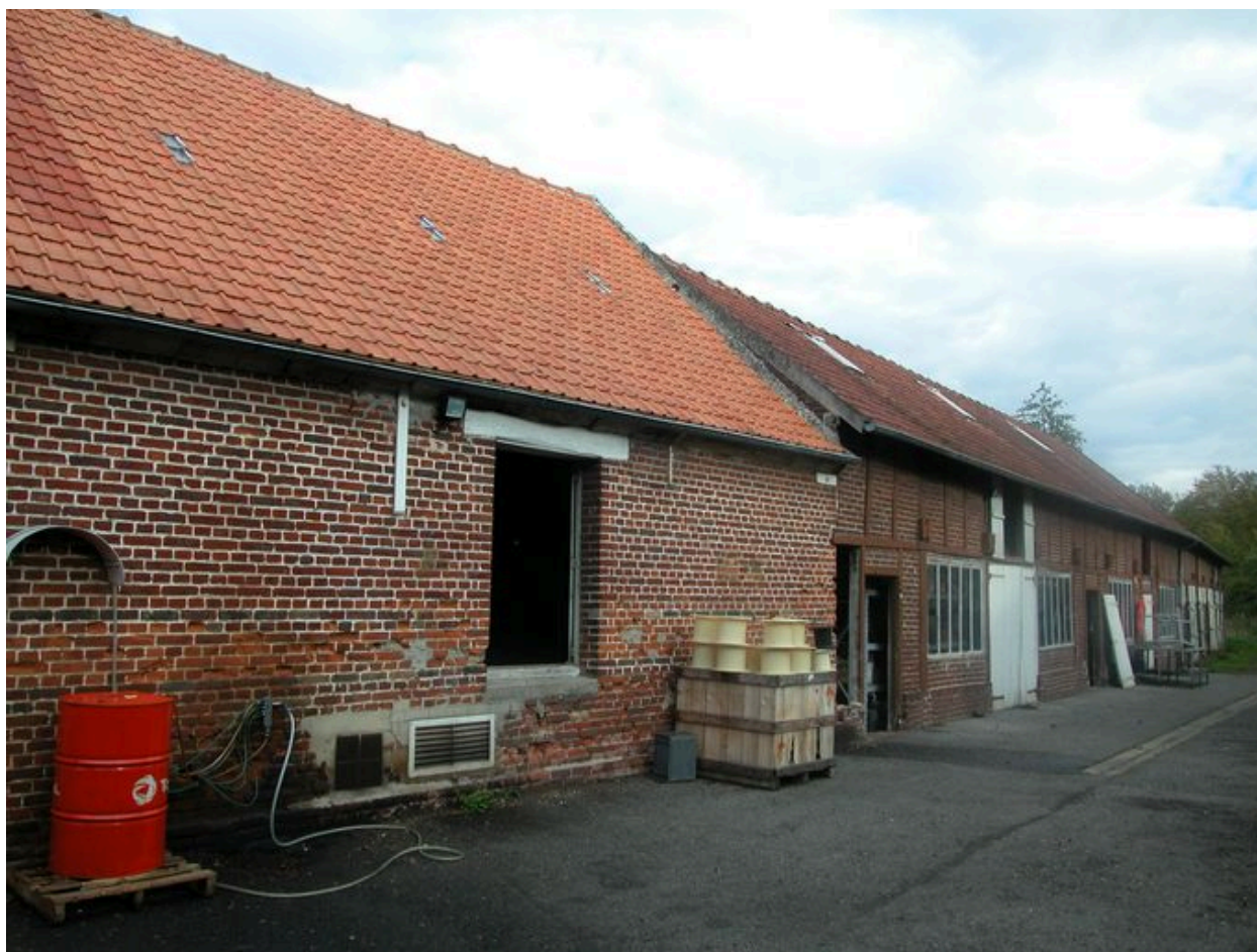
Entrepôt industriel réservé au stockage des bois utilisés pour les manches de brosses.
