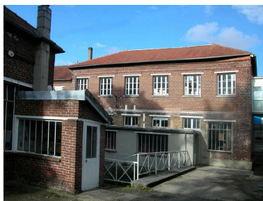
L'atelier de finition (à l'étage) et le bureau de contrôle des produits finis. Phot. Bertrand Fournier IVR22_20046003085NUCA
