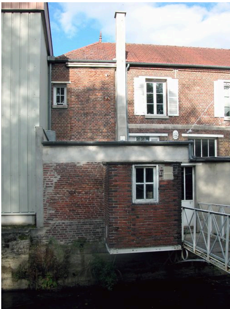
Détail de l'élévation de l'atelier de finition portant la trace de l'ancienne cheminée d'usine.
