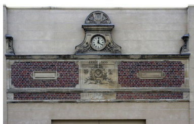
Façade sur rue du magasin industriel, détail du fronton portant la date de 1899. Phot. Thierry Lefébure IVR22_20046000241NUCA
