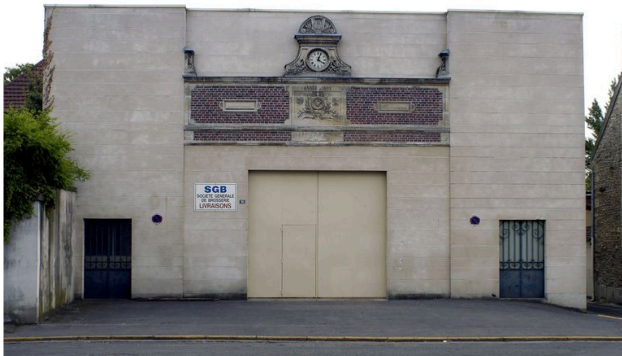
Façade sur rue du magasin industriel.
