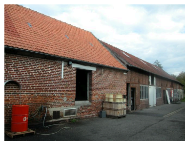
Entrepôt industriel réservé au stockage des bois utilisés pour les manches de brosse. Phot. Bertrand Fournier IVR22_20046003035NUCA
