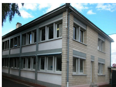
Façade sur cour du bâtiment administratif. Phot. Bertrand Fournier IVR22_20046003041NUCA
