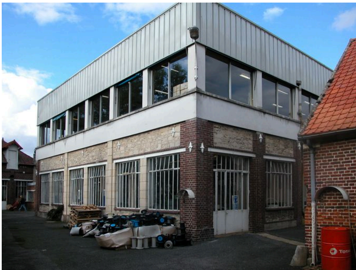
Façade postérieure de l'atelier de fabrication principal.
