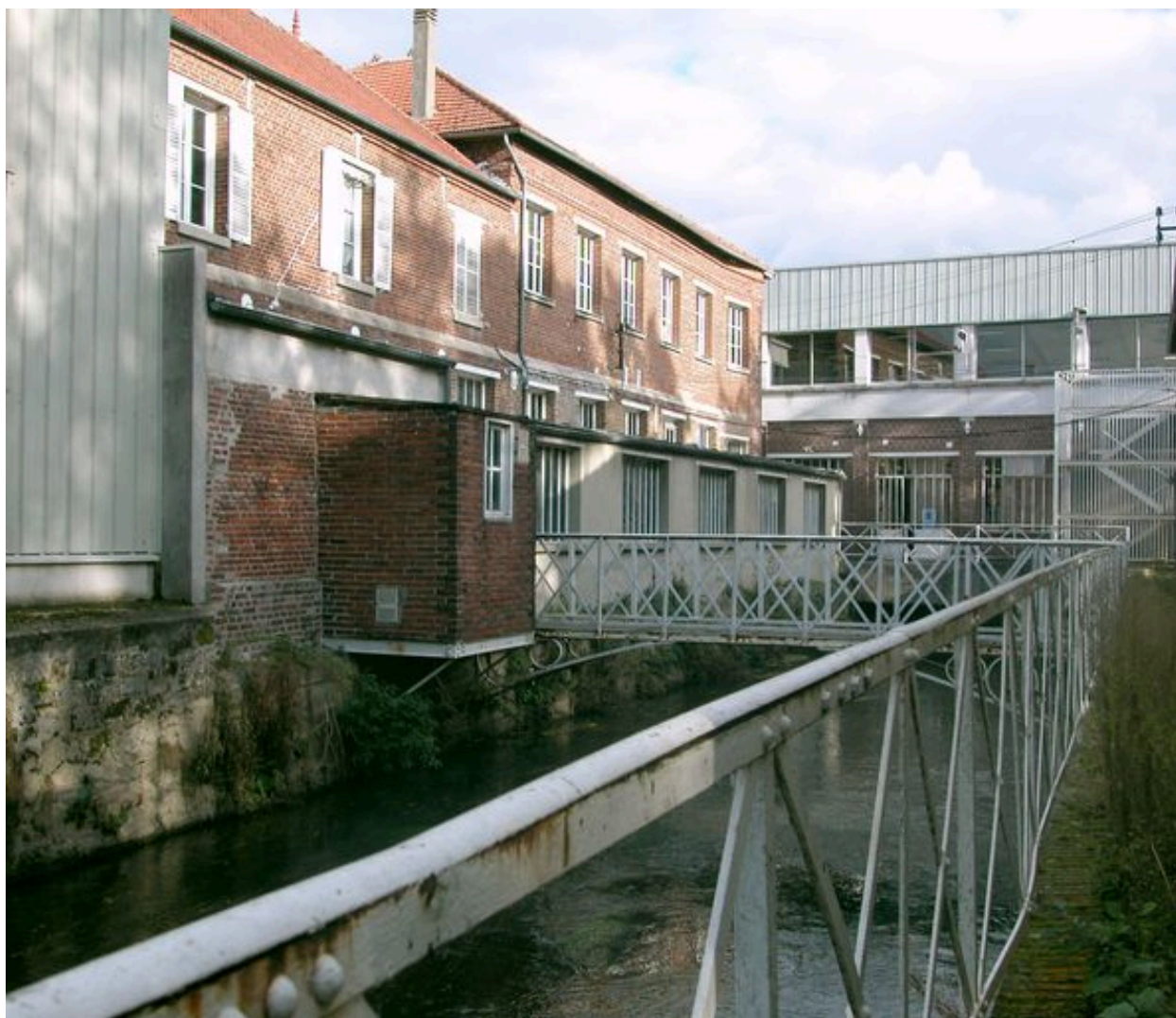
L'atelier de finition et de contrôle des produits finis.
