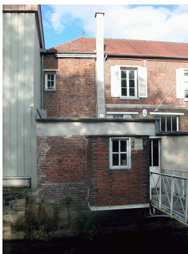
Détail de l'élévation de l'atelier de finition portant la trace de l'ancienne cheminée d'usine. Phot. Bertrand Fournier IVR22_20046003084NUCA
