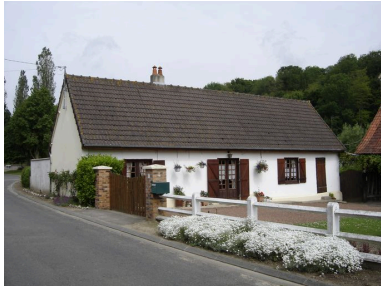
Vue du logis. Phot. Inès Guérin IVR22_20058005950NUCA
