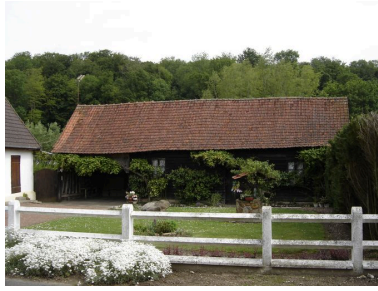
Vue des dépendances. Phot. Inès Guérin IVR22_20058005951NUCA
