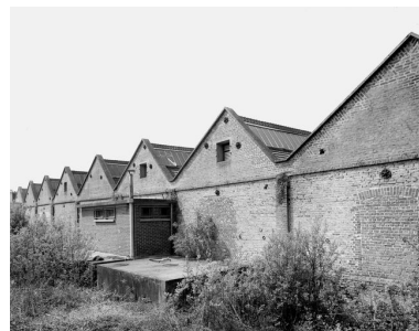
Pignon de l'atelier de tissage, état en 1988.
