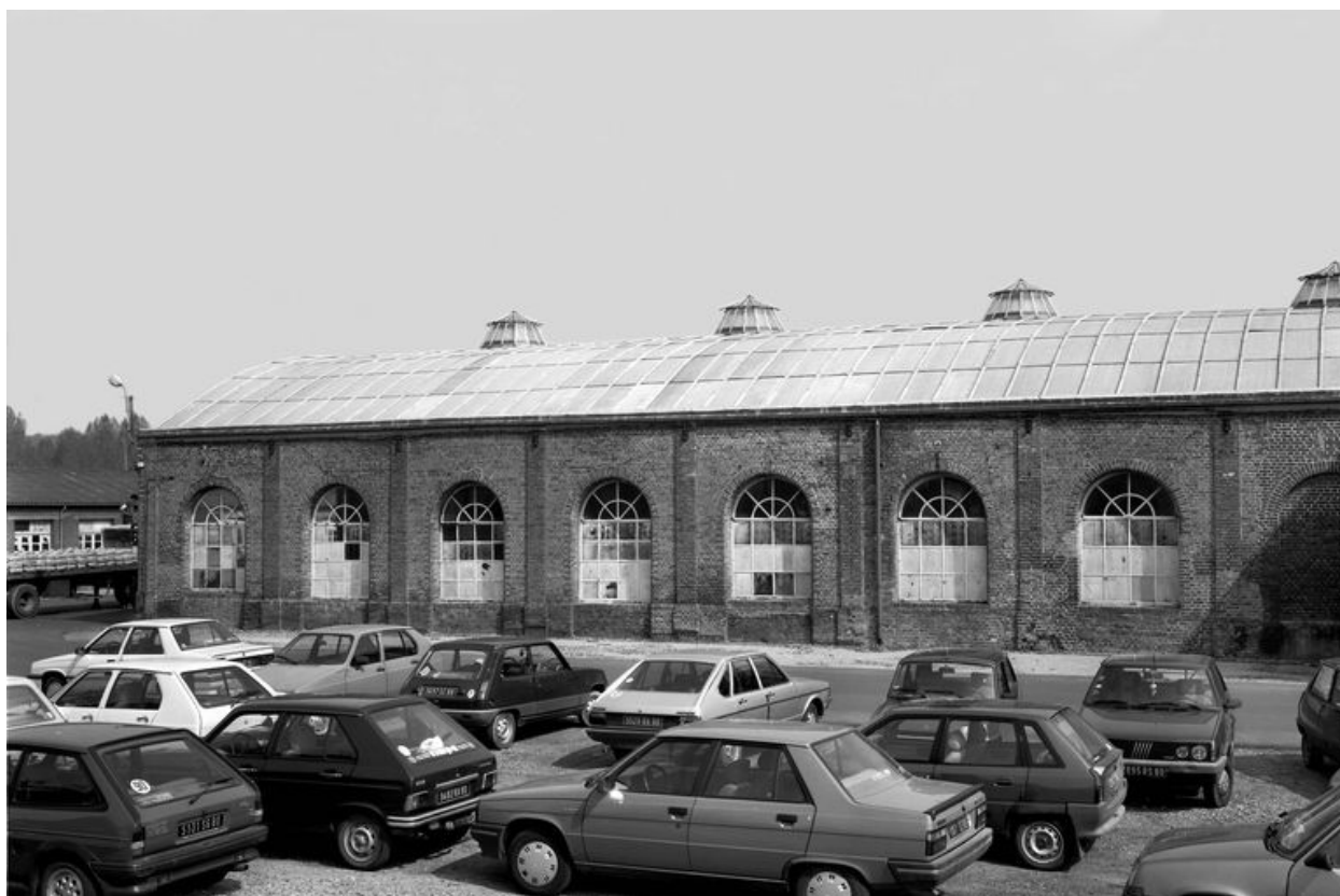
Façade sud de l'ancien atelier de pliage, état en 1988.
