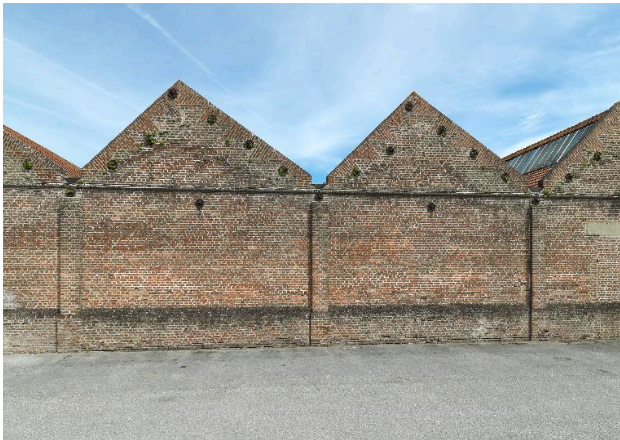
Pignons en sheds de l'atelier de tissage, façade ouest.
