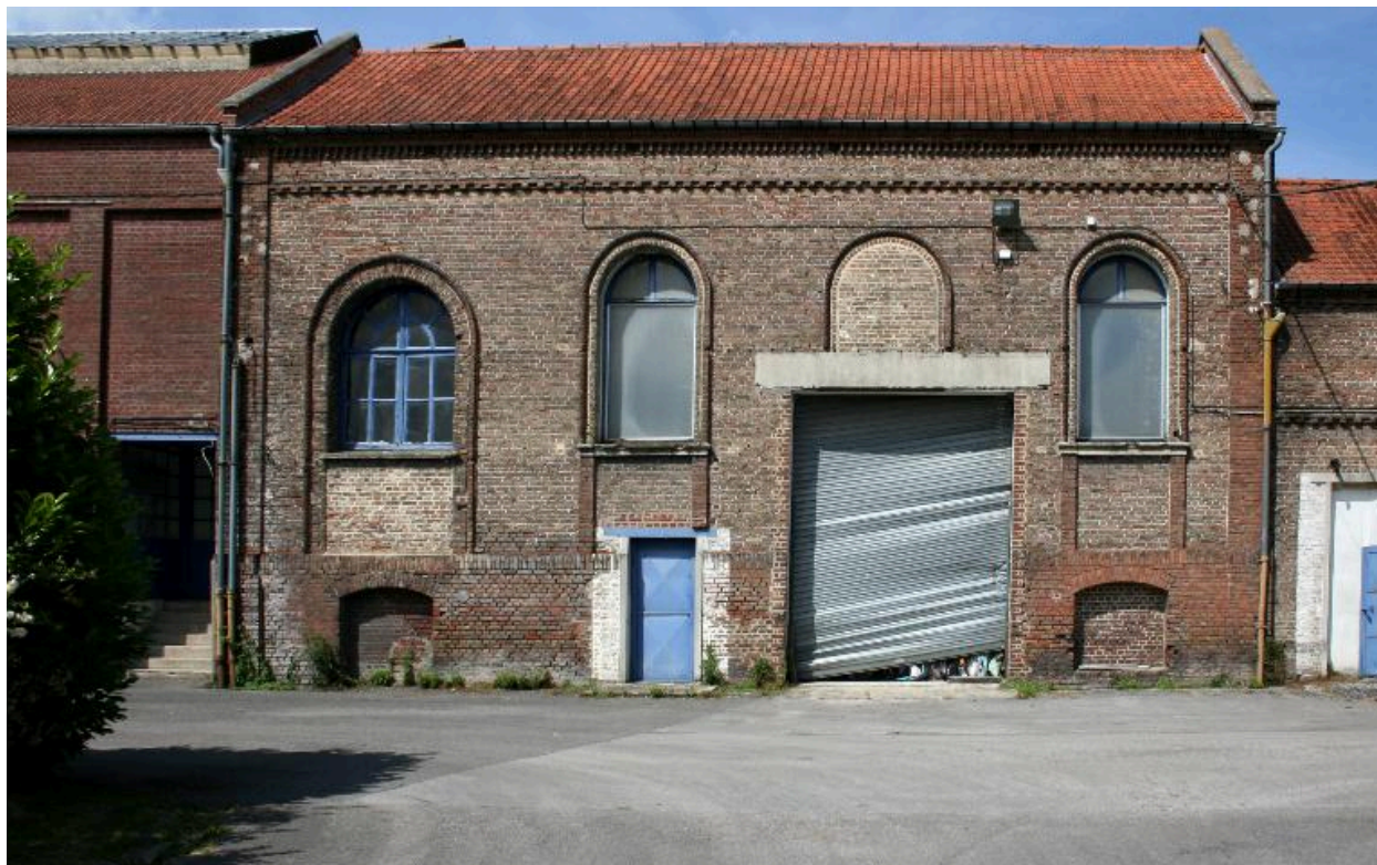
Façade sud de la salle des générateurs.
