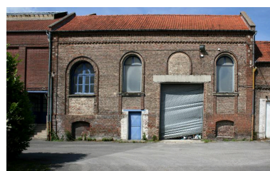
Façade sud de la salle des générateurs. Phot. Bertrand Fournier IVR22_20128005062NUCA
