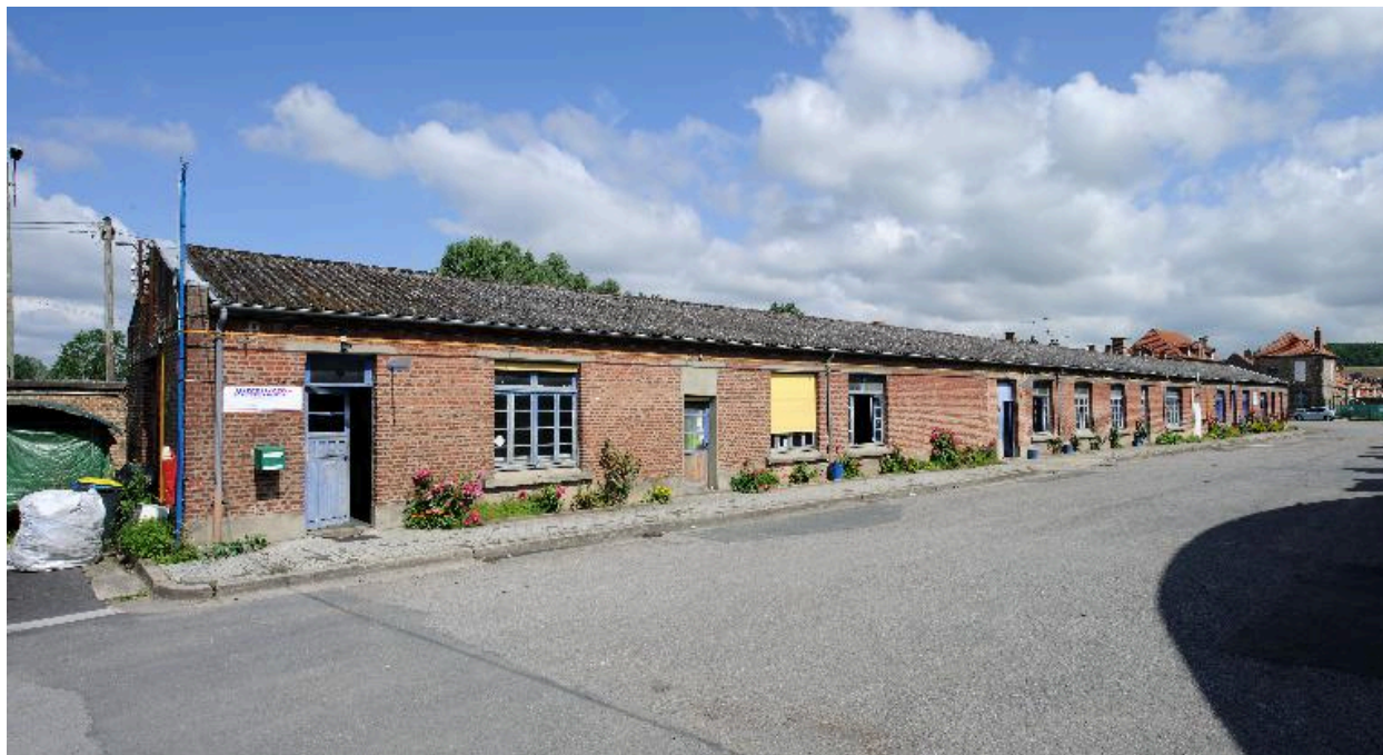
Vue d'ensemble sur cour du réfectoire.
