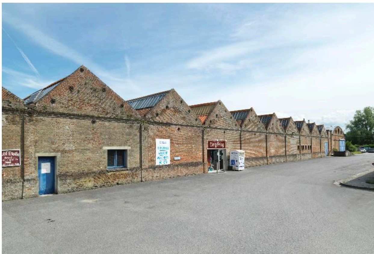
Vue d'ensemble nord-ouest de l'atelier de tissage.
