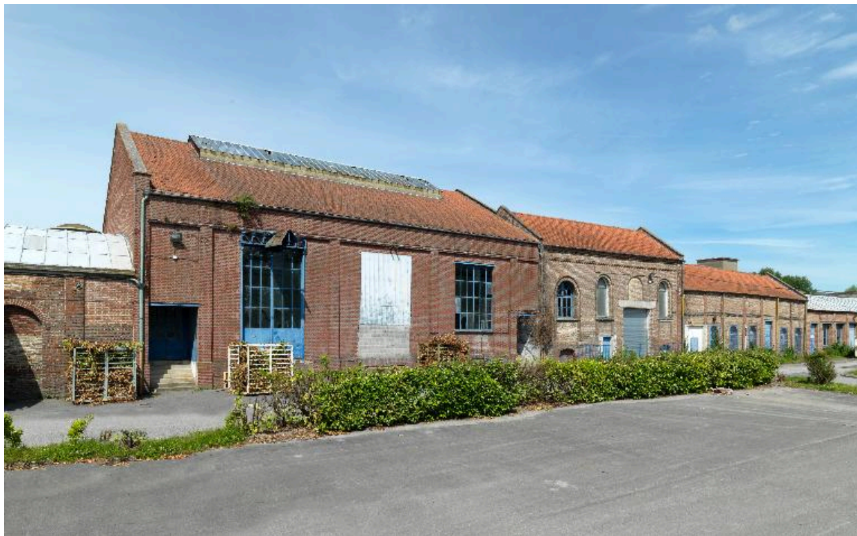
Vue d'ensemble sud de la chaufferie, de la salle des machines et des magasins à fil.
