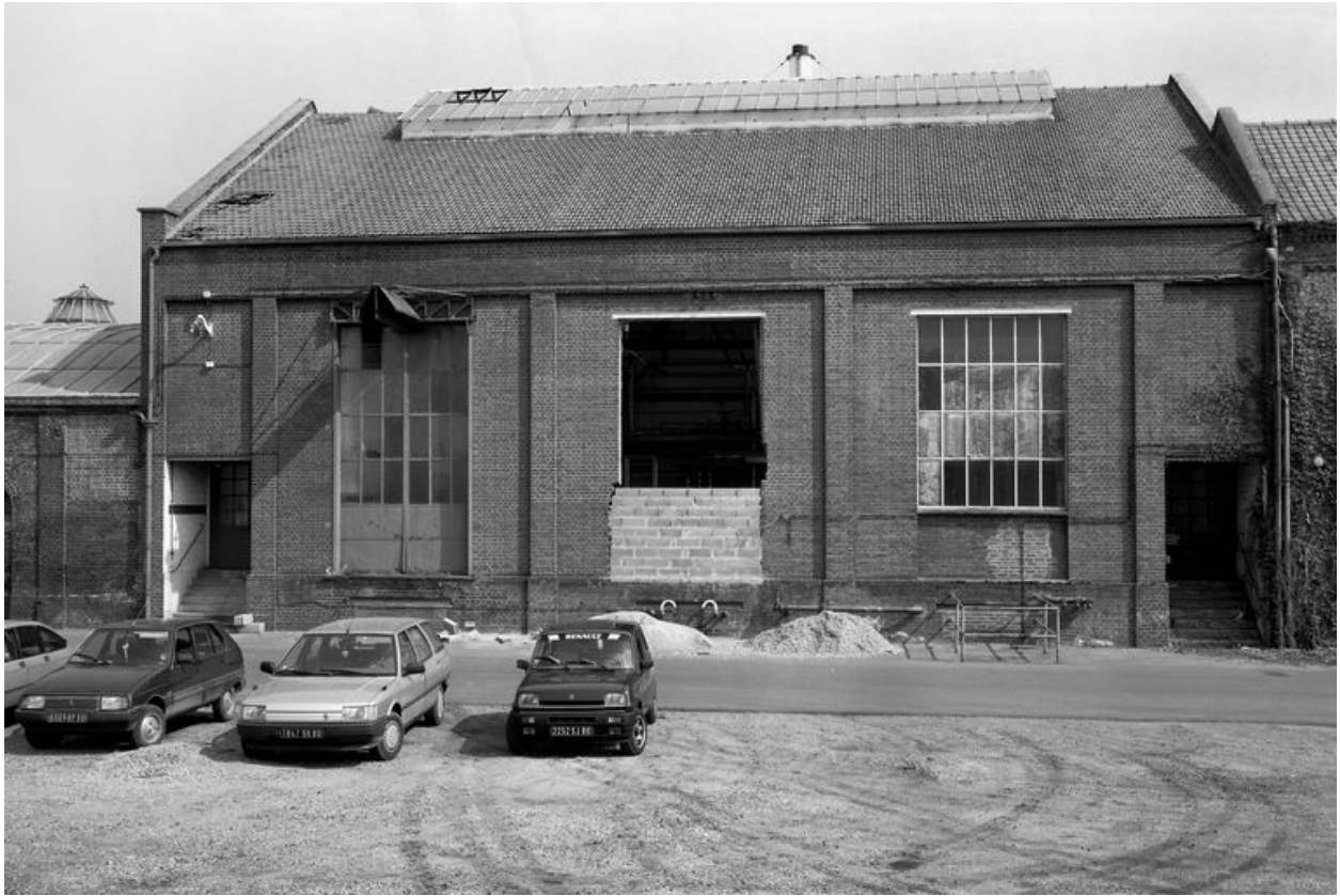
Chaufferie, état en 1988.
