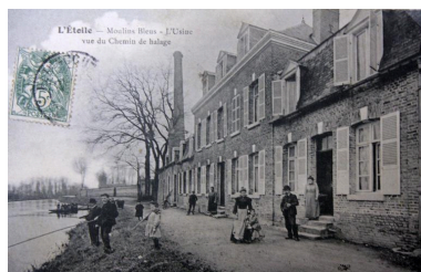
Vue des logements de l'usine des Moulins-Bleus, donnant sur le chemin de halage de la Somme, vers 1906 (L'Étoile ; coll. J. Hérouart). Phot. Fournier Bertrand (reproduction) IVR22_20128005056NUCA
