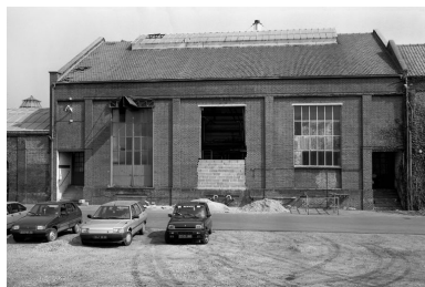
Chaufferie, état en 1988. Phot. Thierry Lefébure IVR22_19888000643X
