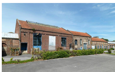
Vue d'ensemble sud de la chaufferie, de la salle des machines et des magasins à fil. Phot. Thierry Lefébure IVR22_20128000265NUC2A
