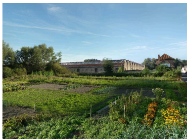
Vue d'ensemble de l'usine des Moulins-Bleus, depuis les jardins ouvriers. Phot. Thierry Lefébure IVR22_20128000601NUC2A
