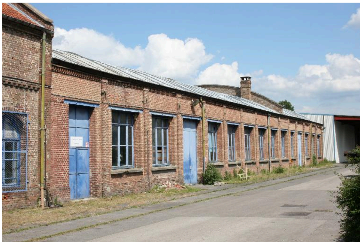
Façade sud des magasins.
