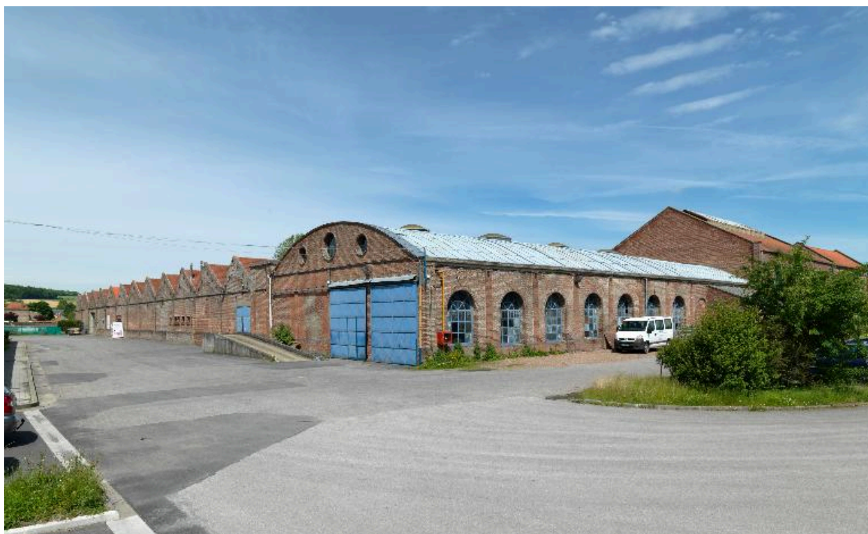
Vue d'ensemble sud-ouest de l'atelier de tissage.
