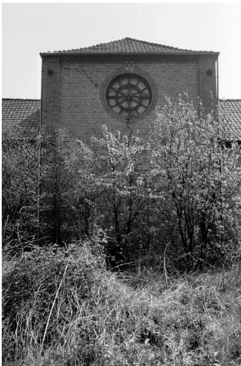
Nef centrale de l'entrepôt à jute, état en 1988.
