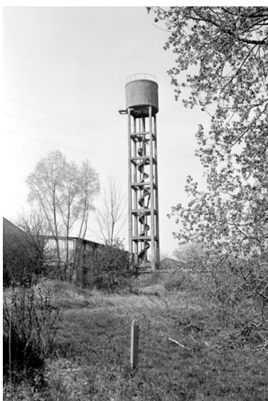
Château d'eau, état en 1988.
