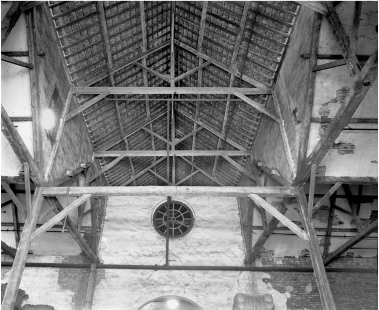
Intérieur de l'entrepôt à jute, état en 1988.
