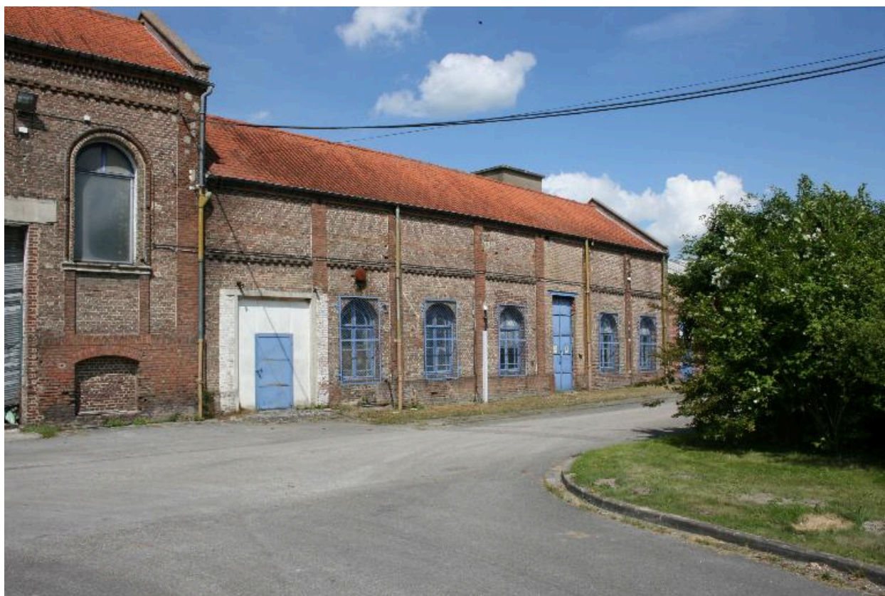
Façade sud du magasin à fil.
