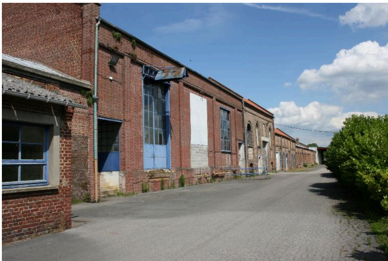
Façade sud des magasins.
