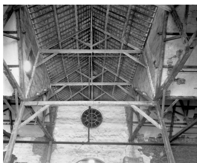
Intérieur de l'entrepôt à jute, état en 1988.
