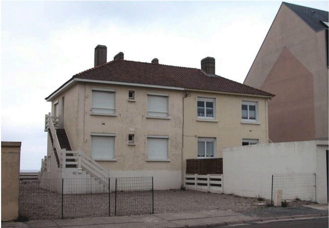
Vue d'ensemble, élévation postérieure.
