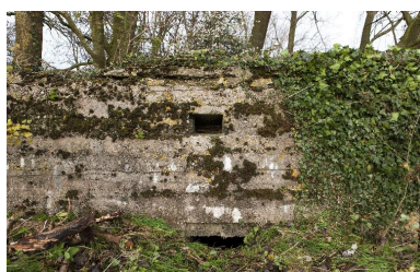
Un des événements du dispositif de dispersion de l'onde de choc en cas d'impact d'un obus Phot. Jean-Marc Ramette IVR31_20145904625NUCA
