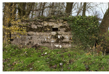
Elévation sud. Au centre un des événements du dispositif de dispersion de l'onde de choc en cas d'impact d'un obus Phot. Jean-Marc Ramette IVR31_20145904626NUCA
