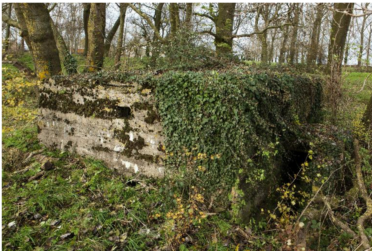
Vue générale vers le nod. L'entrée s'effectuait par le coté droit
