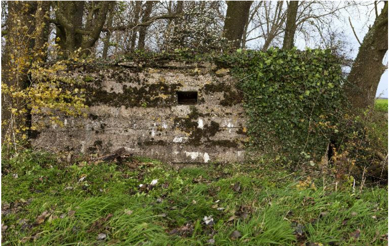
Elévation sud. Au centre un des événements du dispositif de dispersion de l'onde de choc en cas d'impact d'un obus
