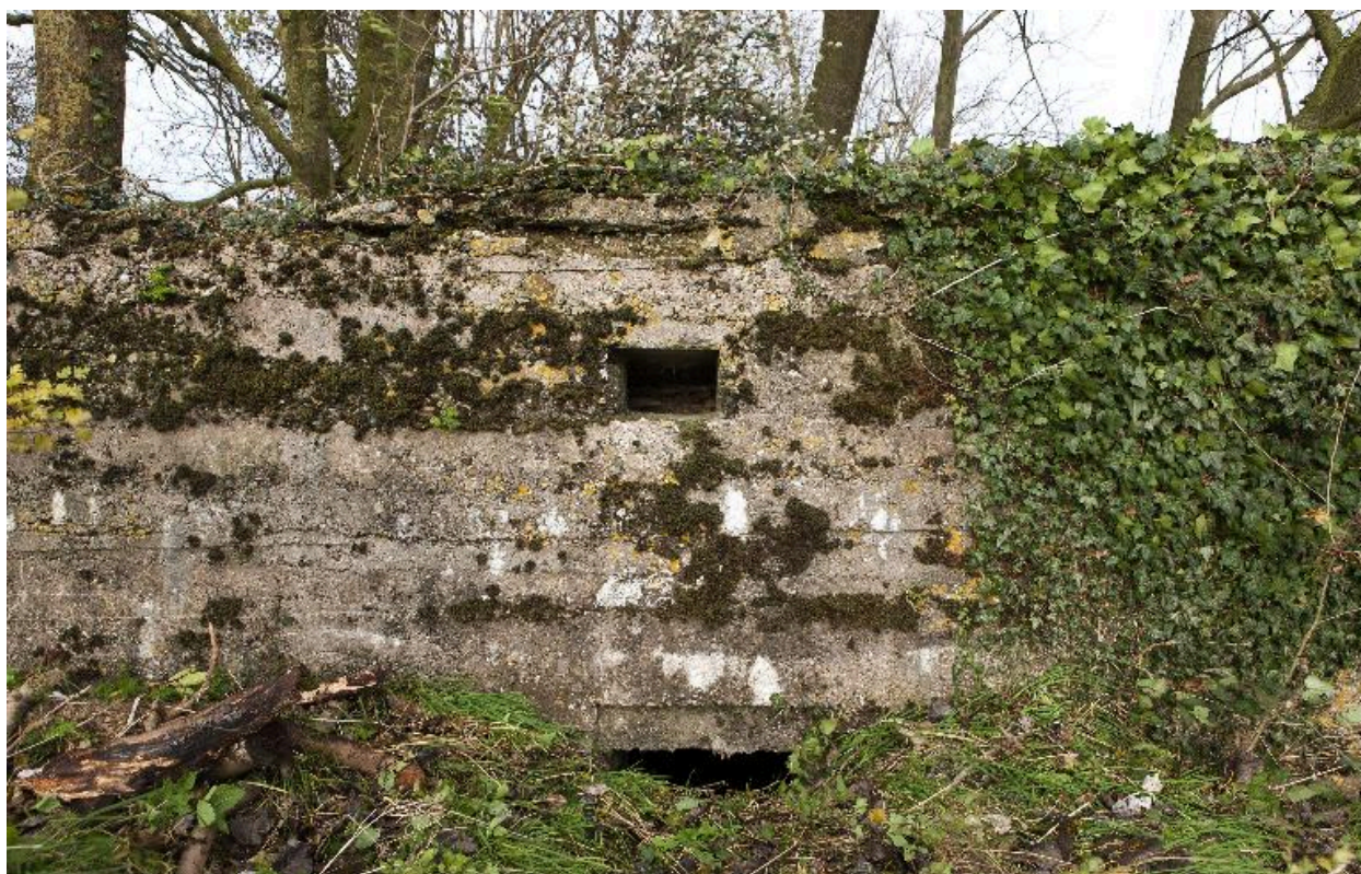
Un des événements du dispositif de dispersion de l'onde de choc en cas d'impact d'un obus
