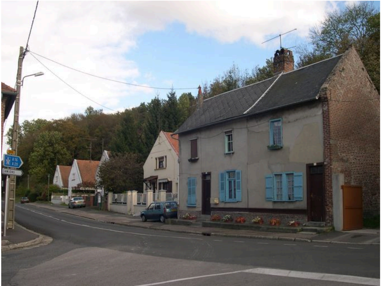
Maison, rue de Conty, milieu 19e siècle.
