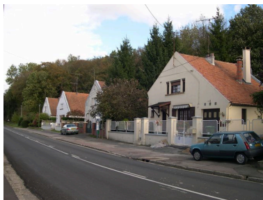
Cité ouvrière, route de Conty. Phot. Isabelle Barbedor IVR22_20048010470NUCA
