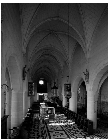
Vue intérieure vers l'entrée. Phot. Jean-Michel Perrin IVR22_19846001321V
