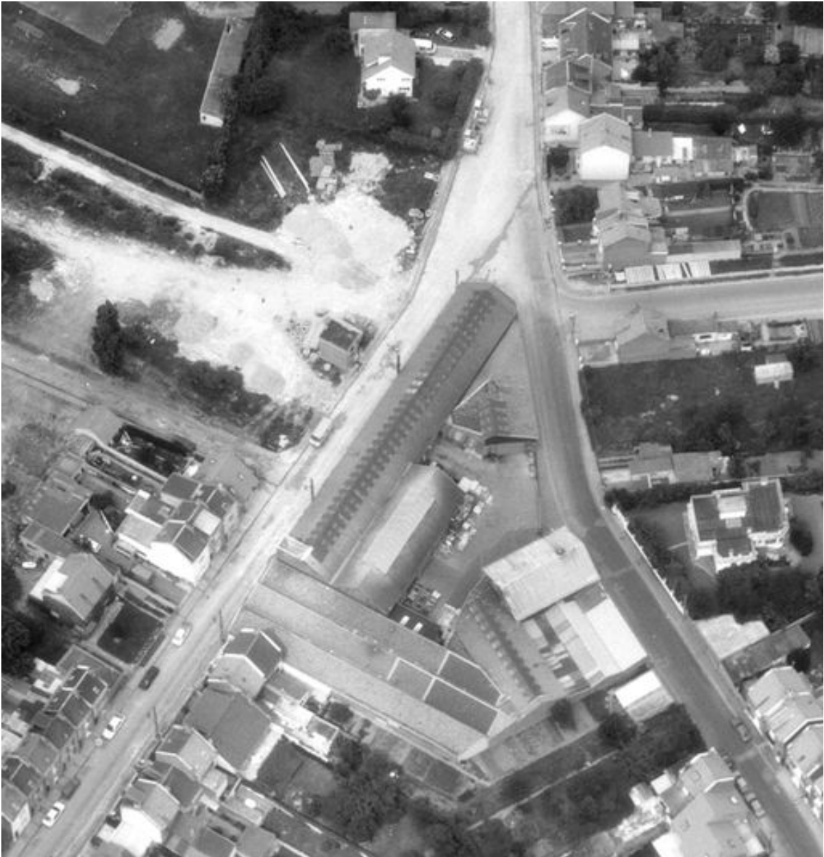
Vue aérienne, flanc sud-ouest.
