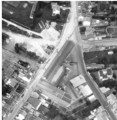
Vue aérienne, flanc sud-ouest.
