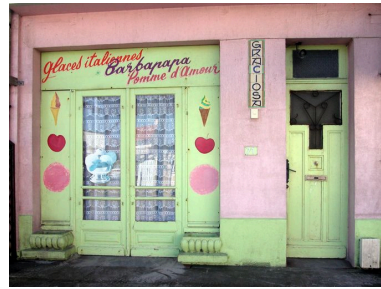
Détail de l'élévation du rez-de-chaussée. Phot. Elisabeth Justome IVR22_20058002763NUCA
