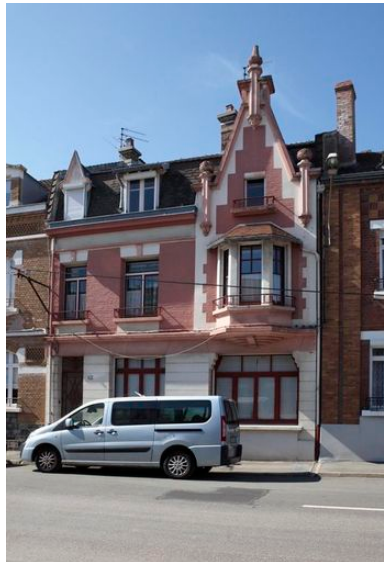
Vue générale. Phot. Pierre Thibaut IVR31_20086200193NUCA
