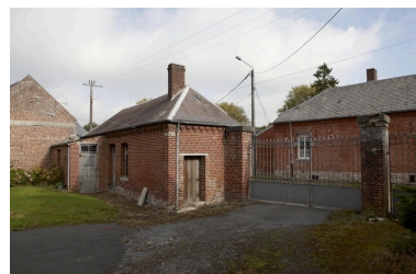
Vue de la maisonnette située à l'entrée. Phot. Pierre Thibaut IVR31_20095903252NUCA
