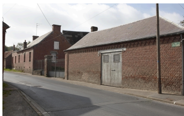
Vue générale de la ferme depuis la voie : le garage et le logis. Phot. Pierre Thibaut IVR31_20095903257NUCA
