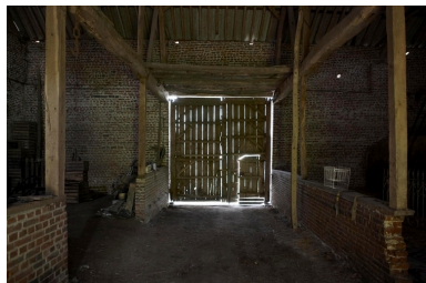
Vue intérieure de la grange. Phot. Pierre Thibaut IVR31_20095903250NUCA
