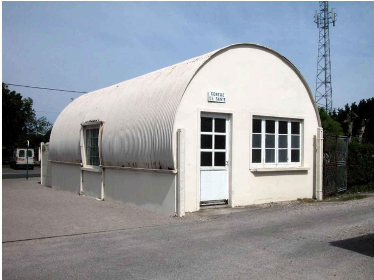
Le dispensaire, construction type de l'après-guerre.
