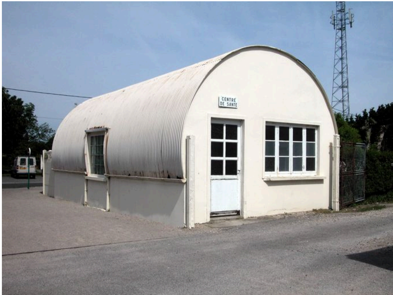
Le dispensaire, construction type de l'après-guerre.
