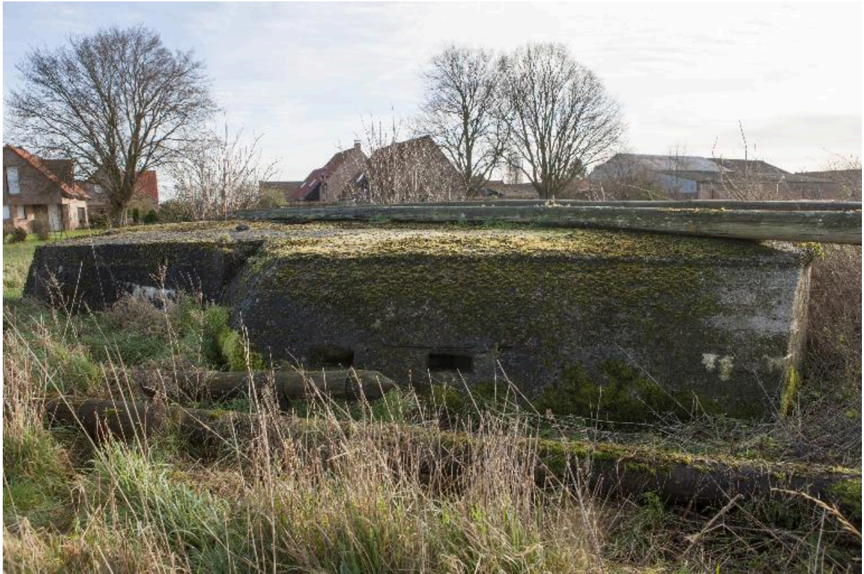
Casemate B : Élévation ouest. A gauche deux créneaux de fusillade ou d'observation.
