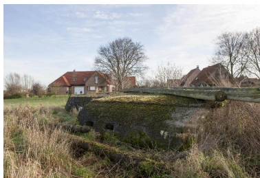
Casemate B : Vue de trois- quarts vers le nord-est Phot. Pierre Thibaut IVR32_20165900009NUCA
