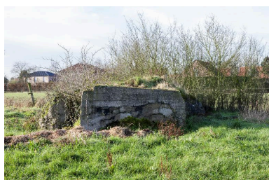
Casemate A : Vue générale vers sud-ouest Phot. Pierre Thibaut IVR32_20165900002NUCA
