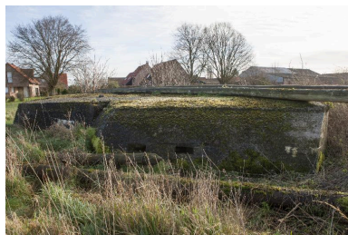
Casemate B : Elévation ouest. A gauche deux créneaux de fusillade ou d'observation. Phot. Pierre Thibaut IVR32_20165900010NUCA
