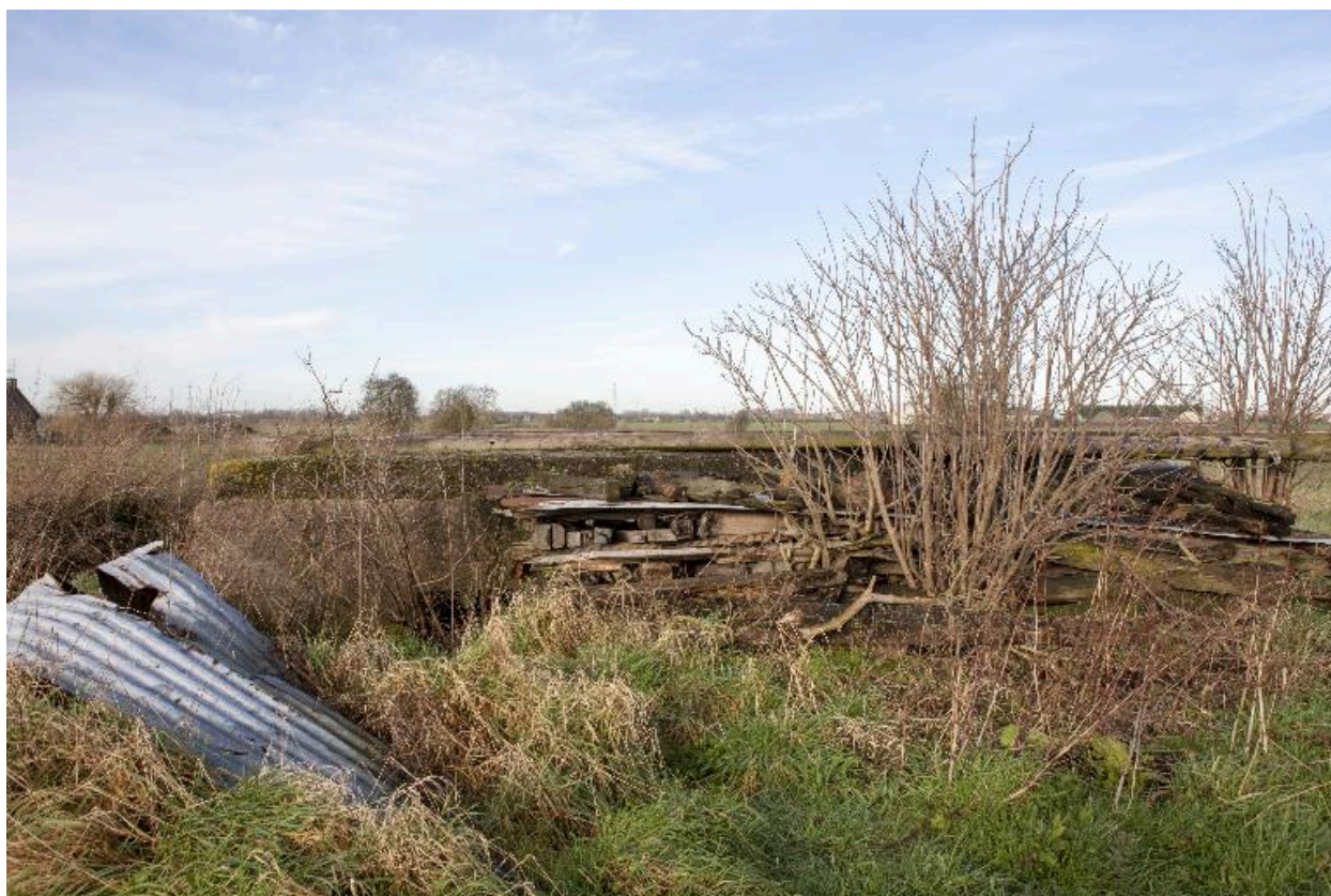
Casemate B : Vue générale, vers l'ouest
