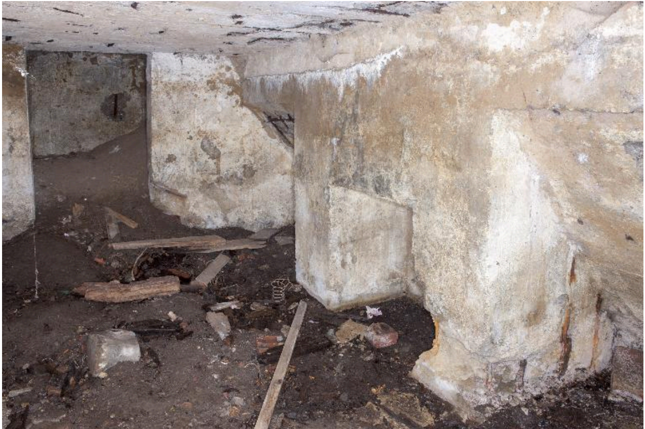
Casemate B : Vue intérieure, vers le sud
