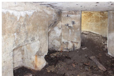
Casemate B : Vue intérieure, vers le nord Phot. Pierre Thibaut IVR32_20165900012NUCA
