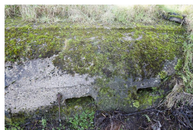
Casemate A : Créneaux de fusillade ou d'observation sur l'élévation nord-ouest Phot. Pierre Thibaut IVR32_20165900004NUCA
