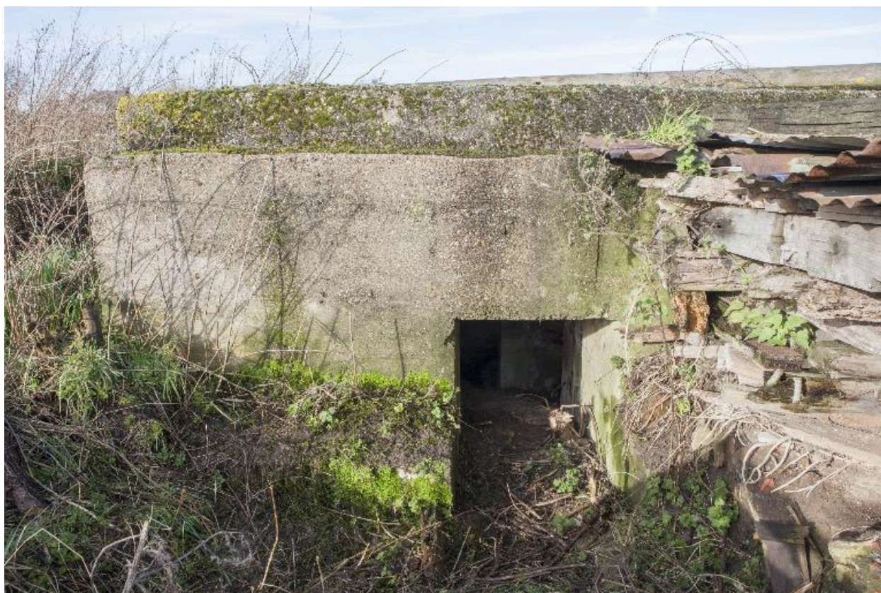
Casemate B : Elévation est, entrée sud.
