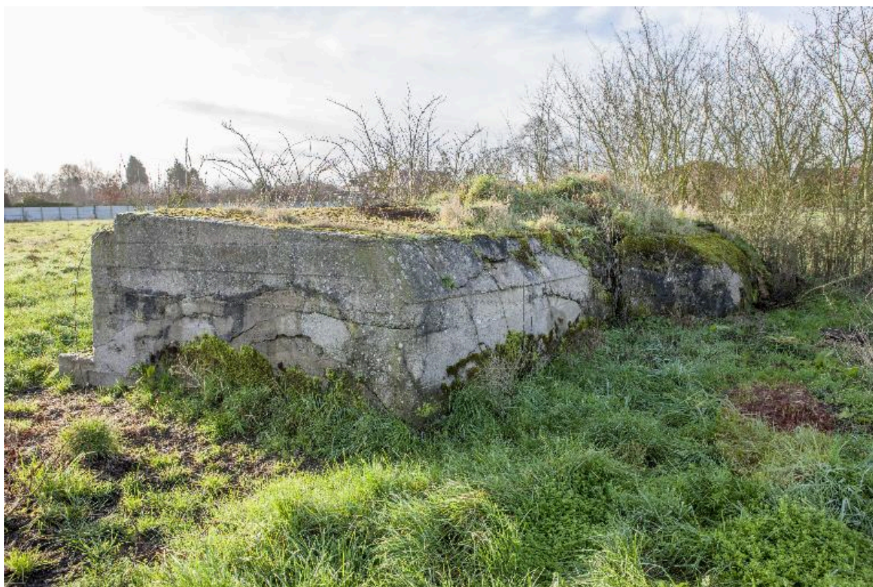
Casemate A : Vue générale vers le sud
