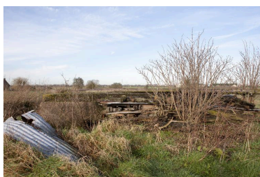
Casemate B : Vue générale, vers l'ouest Phot. Pierre Thibaut IVR32_20165900007NUCA
