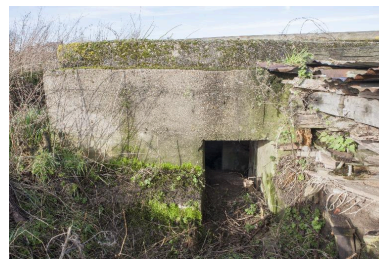
Casemate B : Elévation est, entrée sud. Phot. Pierre Thibaut IVR32_20165900013NUCA
