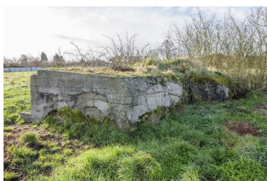
Casemate A : Vue générale vers le sud Phot. Pierre Thibaut IVR32_20165900005NUCA
