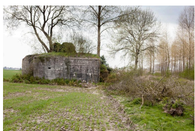
Edifice b : Elévation nord-est
