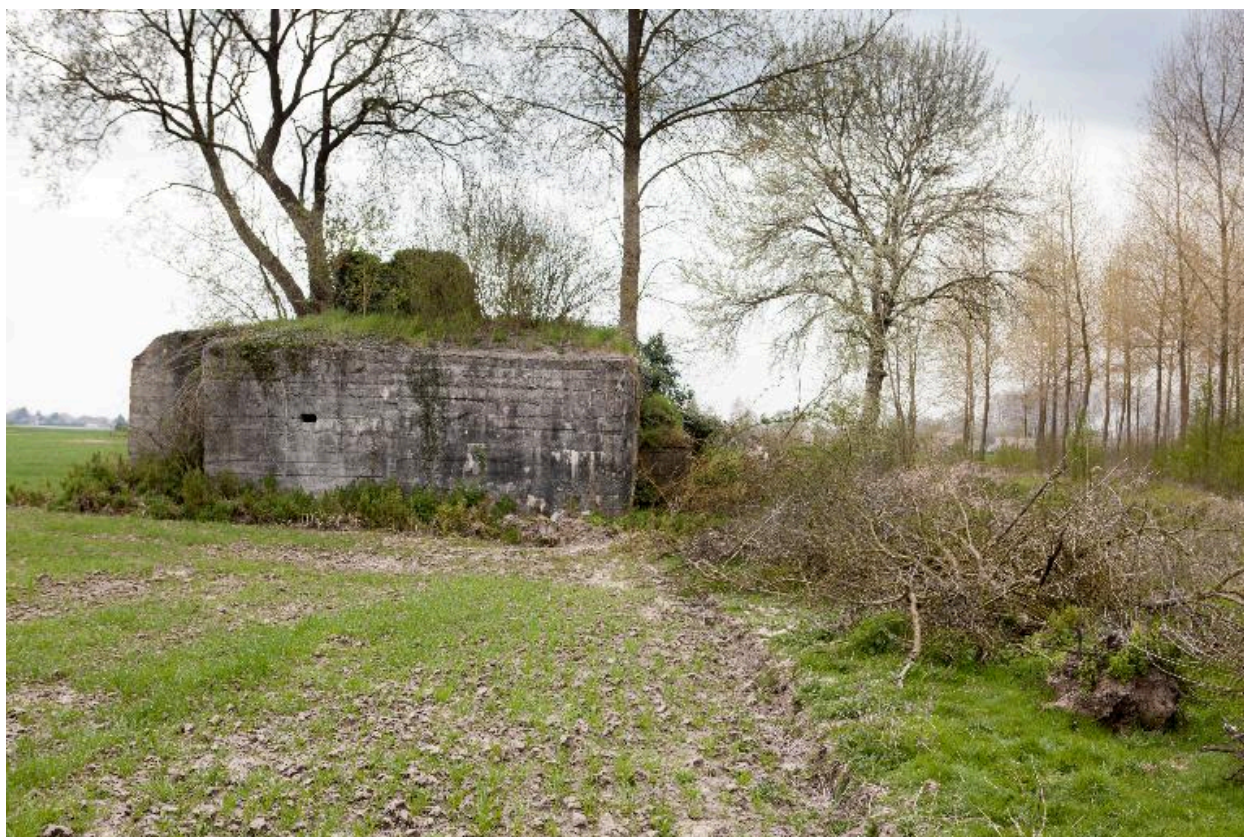
Edifice b : Elévation nord-est
