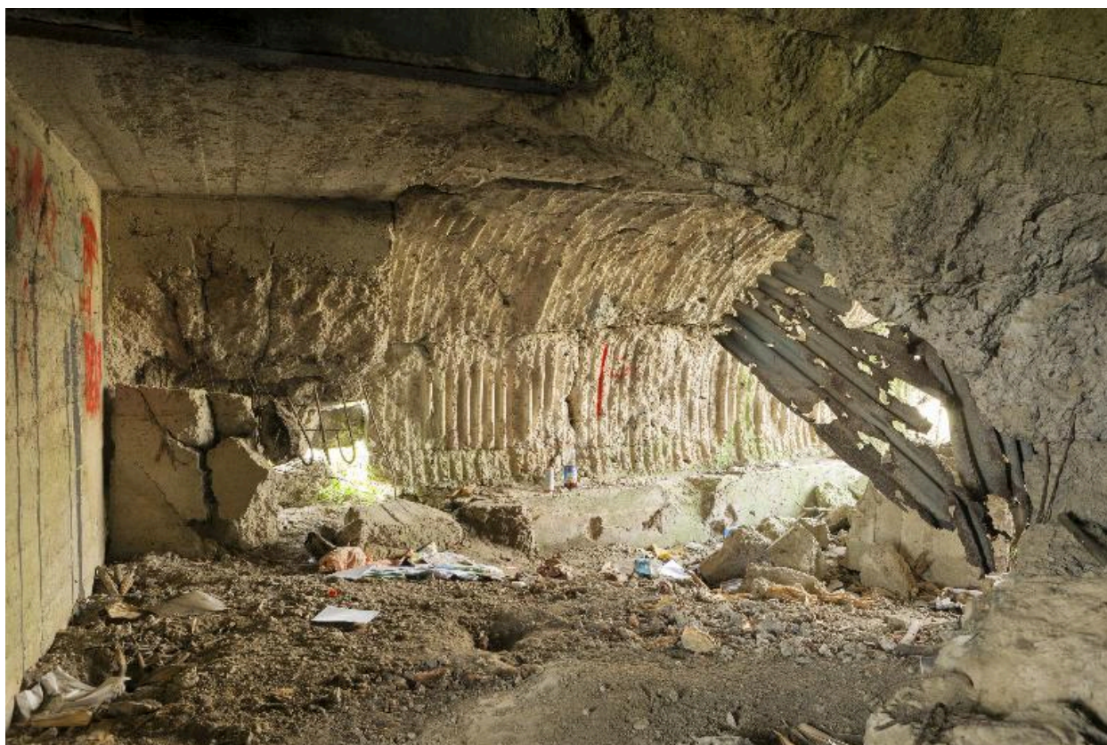
Edifice b. Vue intérieure depuis l'entrée
