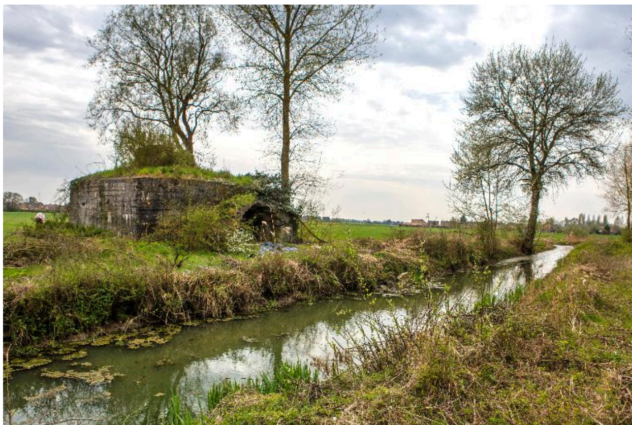
Edifice b. Vue générale vers le sud-ouest
