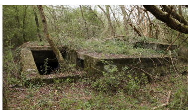
Entrée de l'édifice a Phot. Hubert Bouvet IVR31_20156200319NUCA
