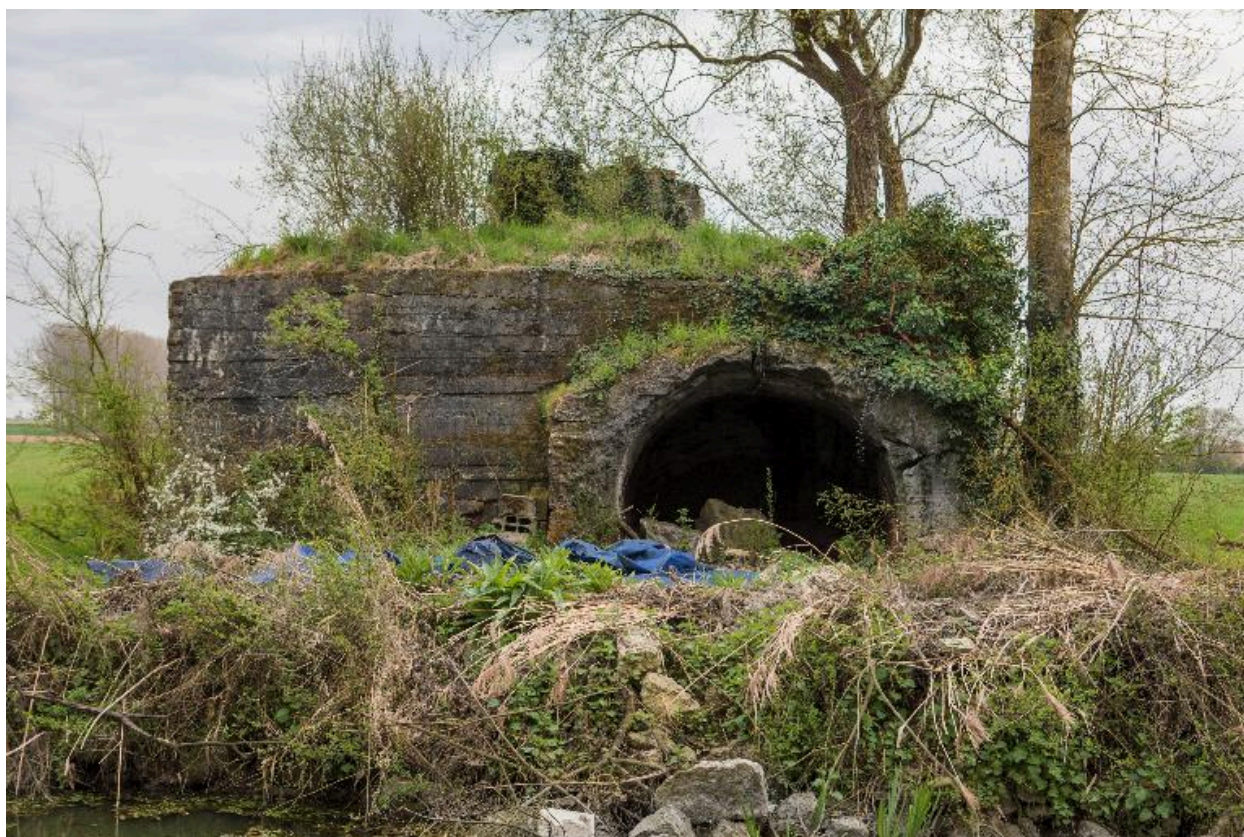
Edifice b, vers le sud
