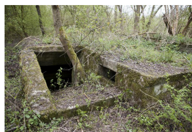
Entrée de l'édifice a Phot. Hubert Bouvet IVR31_20156200317NUCA
