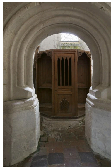
Arcade à voûture menant à une chapelle latérale, au nord du porche. Phot. Thierry Lefébure IVR22_20148000246NUC2A
