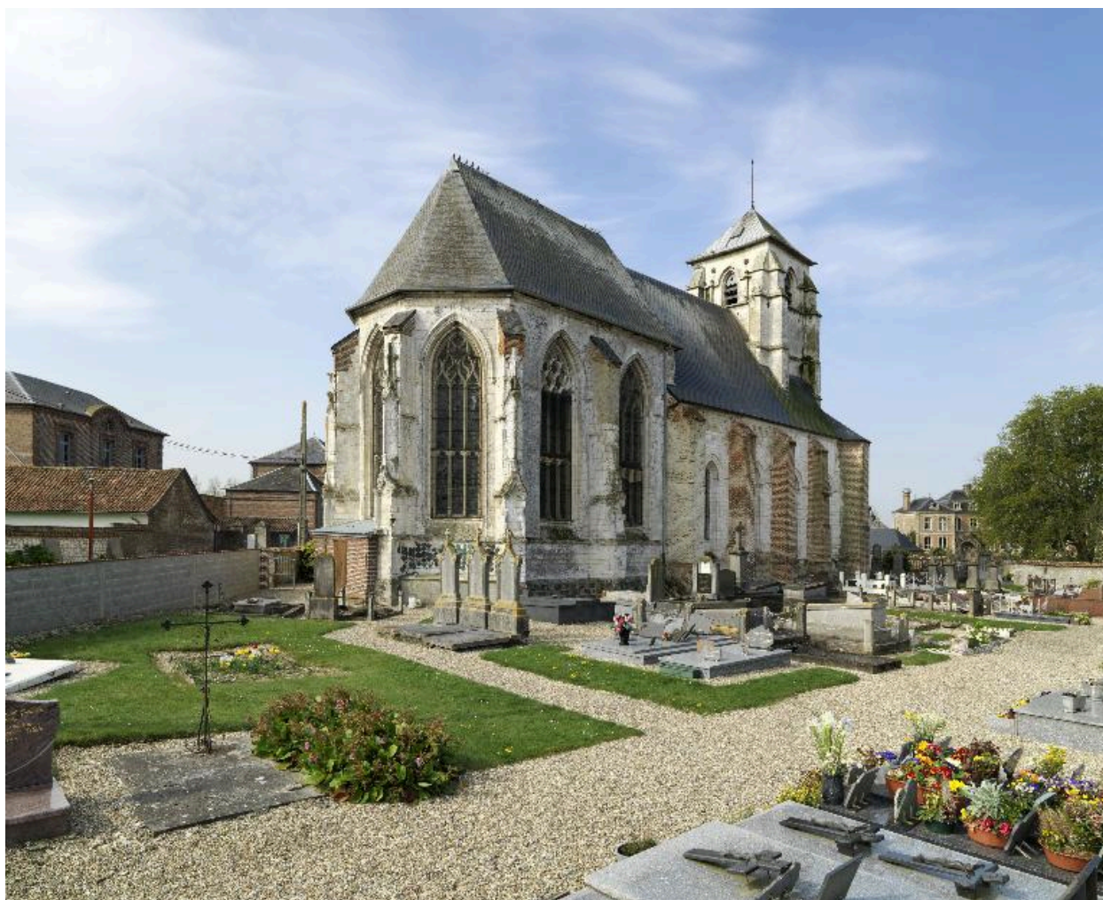
Vue générale du chevet et du flanc nord.
