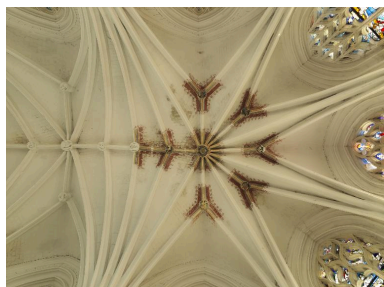
Voûte d'ogives et à nervures multiples du chœur. Phot. Thierry Lefébure IVR22_20148000239NUC2A
