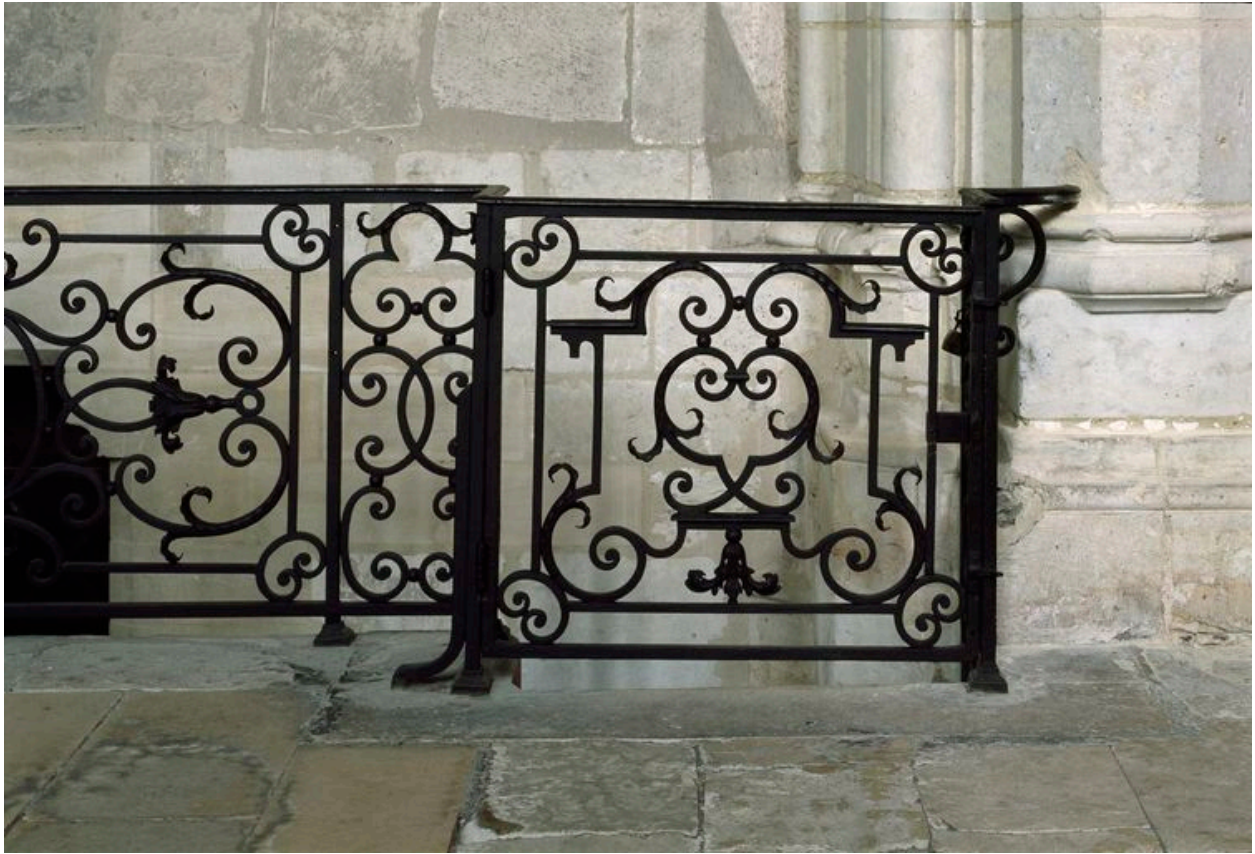
Détail de la porte.
