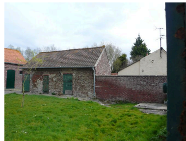
Vue des étables à l'est de la cour. Phot. Inès Guérin IVR22_20078005711NUCA
