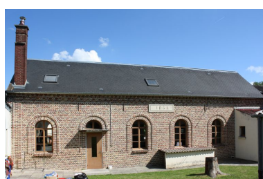
Façade postérieure de l'ancienne école de filles. Phot. Bertrand Fournier IVR22_20088015430NUCA
