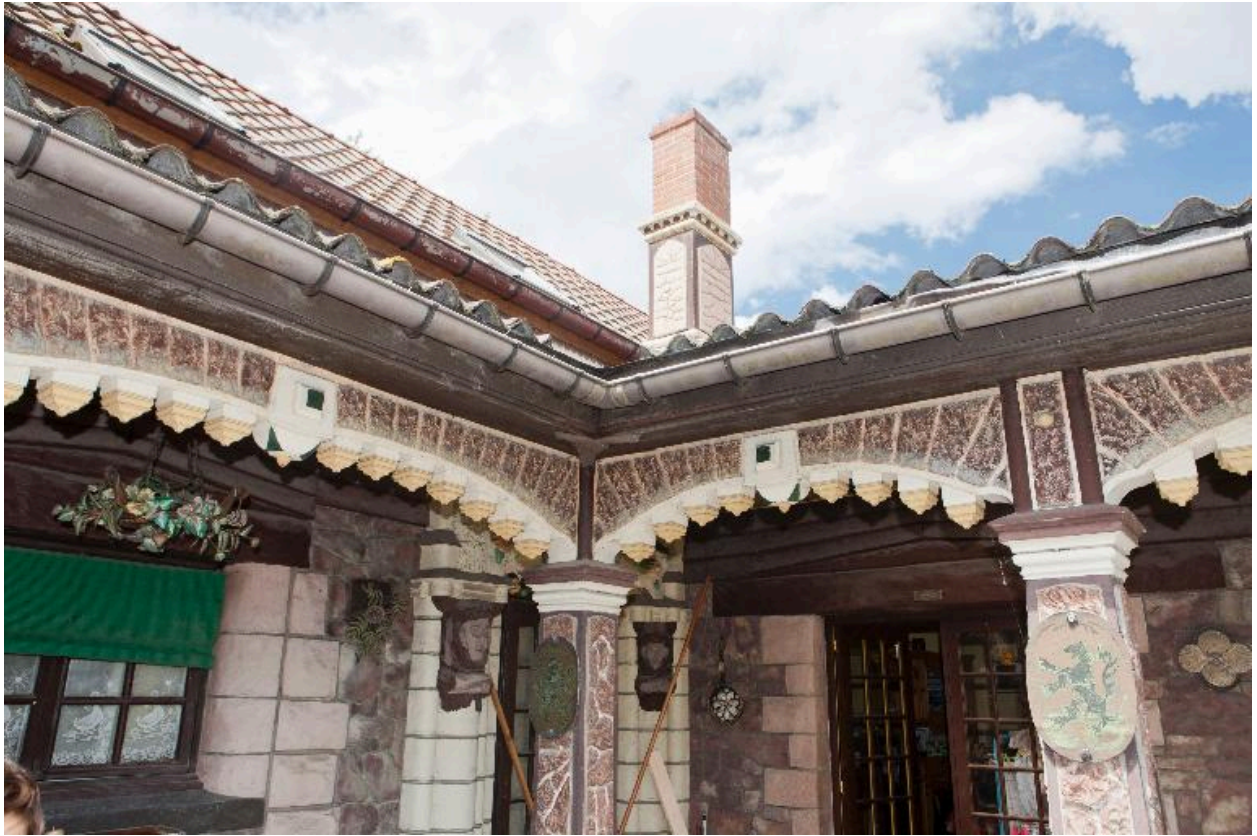
Terrasse, détail des arcades.
