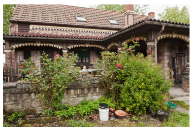
Vue partielle de la maison. Phot. Hubert Bouvet IVR31_20145902913NUC4A
