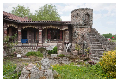
Vue partielle de la maison avec la tour de guet. Phot. Hubert Bouvet IVR31_20145902915NUC4A
