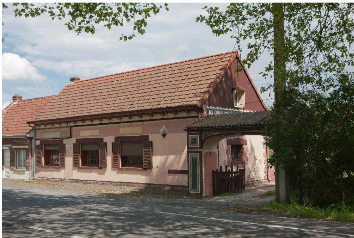
Vue générale sur rue.
