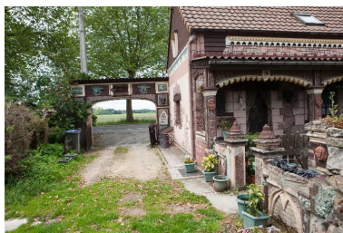
Vue partielle de la maison et de la porte cochère. Phot. Hubert Bouvet IVR31_20145902871NUC4A
