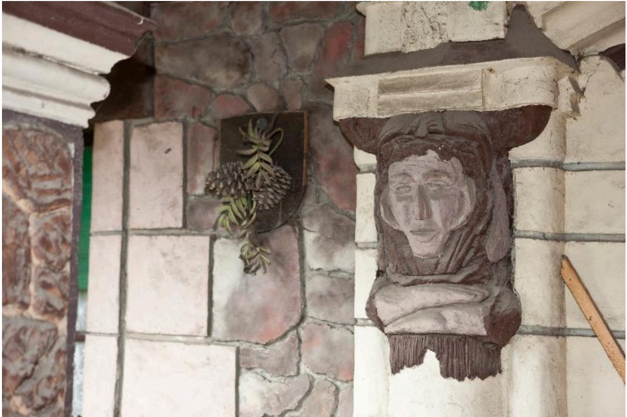
Détail de piliers d'arcade.
