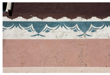
Mur de la maison, détail. Phot. Hubert Bouvet IVR31_20145902875NUC4A
