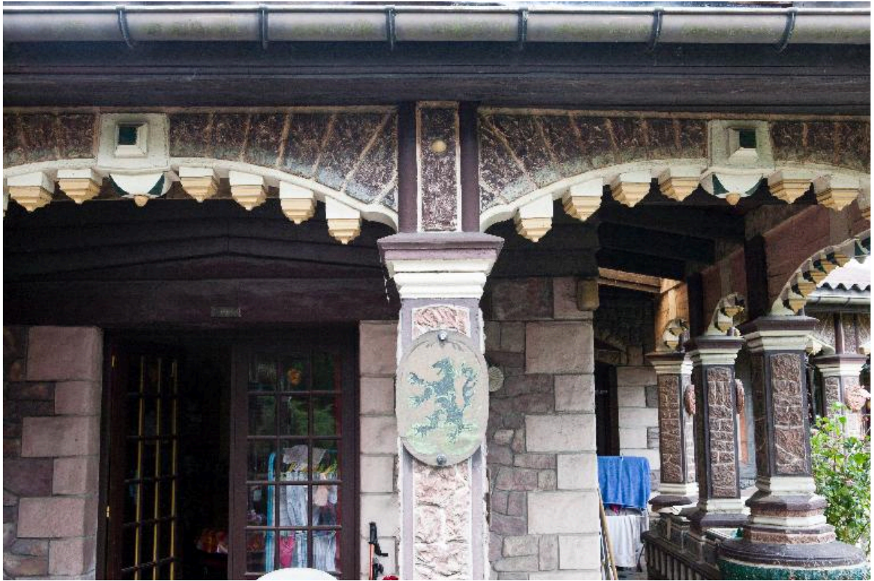
Terrasse, détail des arcades.
