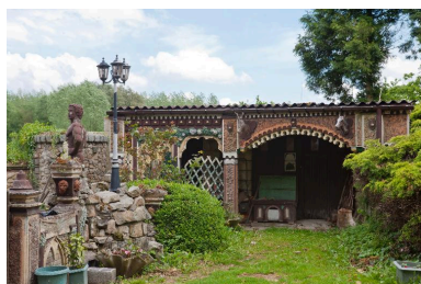
Vue générale depuis l'entrée. Phot. Hubert Bouvet IVR31_20145902888NUC4A
