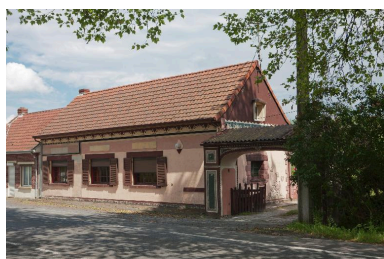
Vue générale sur rue. Phot. Hubert Bouvet IVR31_20145902869NUC4A
