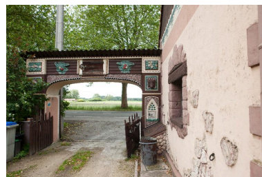
Porte cochère côté jardin, vue partielle. Phot. Hubert Bouvet IVR31_20145902870NUC4A
