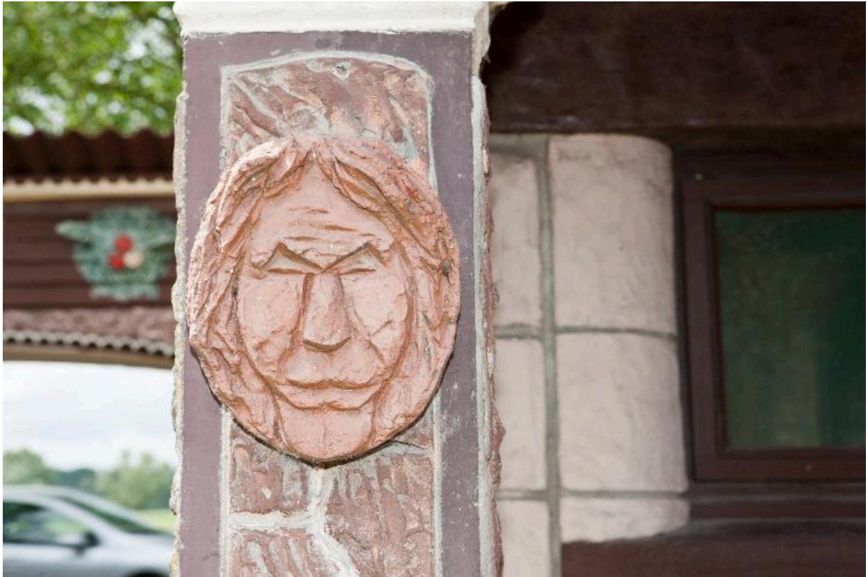
Détail de piliers d'arcade.
