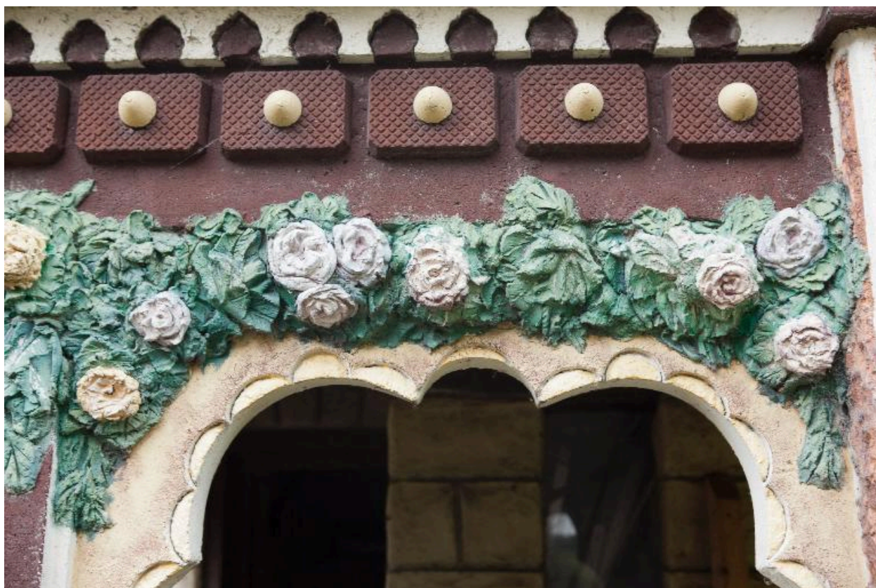
Terrasse, détail des arcades.
