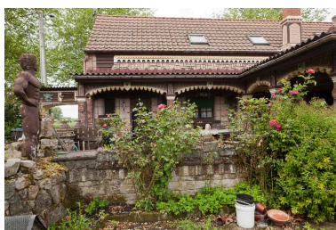
Vue partielle de la maison. Phot. Hubert Bouvet IVR31_20145902912NUC4A
