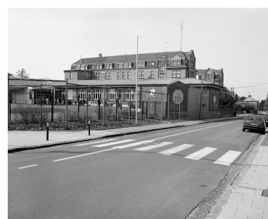
Pensionnat du lycée Jeanne-d'Arc construit par l'architecte Fernand Dumont (1884-1971) en 1941. Phot. Thierry Petitberghien IVR31_20025901231X
