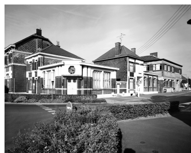
École de Feignies construite par l'architecte Adolphe Danis (1886-1969) en 1928. Phot. Thierry Petitberghien IVR31_20025902009V
