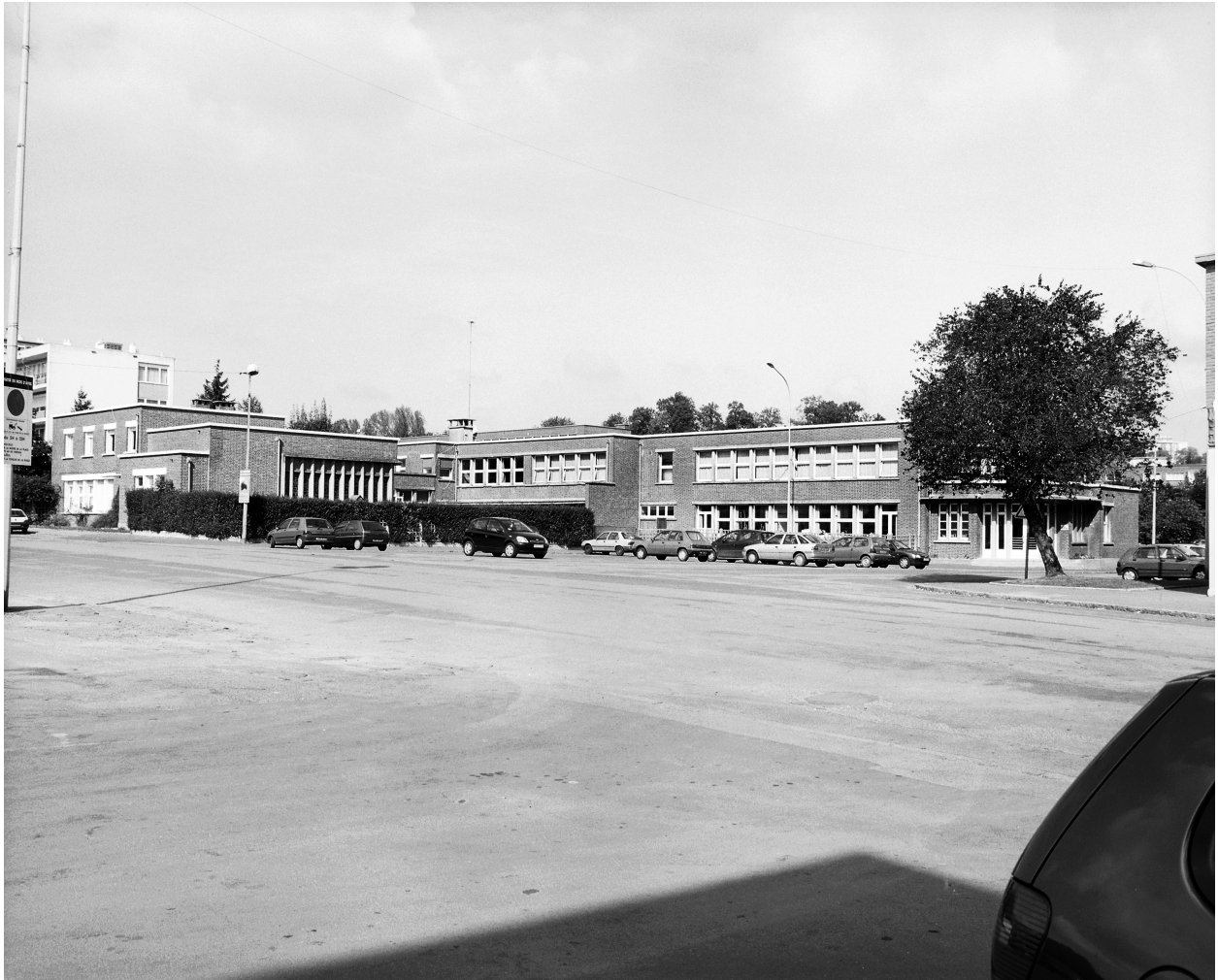
École Notre-Dame-de-Grâce construite par l'architecte Jean Gélis (1920-2007) en 1953.
