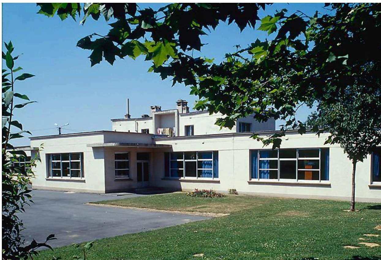
École de Pont-Allant construite par les architectes André Lurçat (1884-1970) et Éric Laffite (né en 1923) en 1958.
