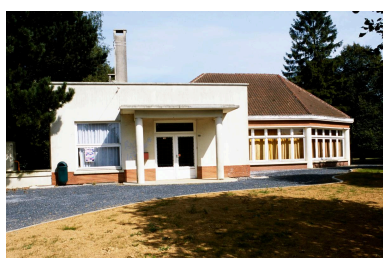
Groupe scolaire intercommunal d'Aulnoye-Aymeries-Bachant construit par l'architecte Armand-Ernest Lemay (1901-1957) vers 1955. Phot. Thierry Petitberghien IVR31_20015901749ZA
