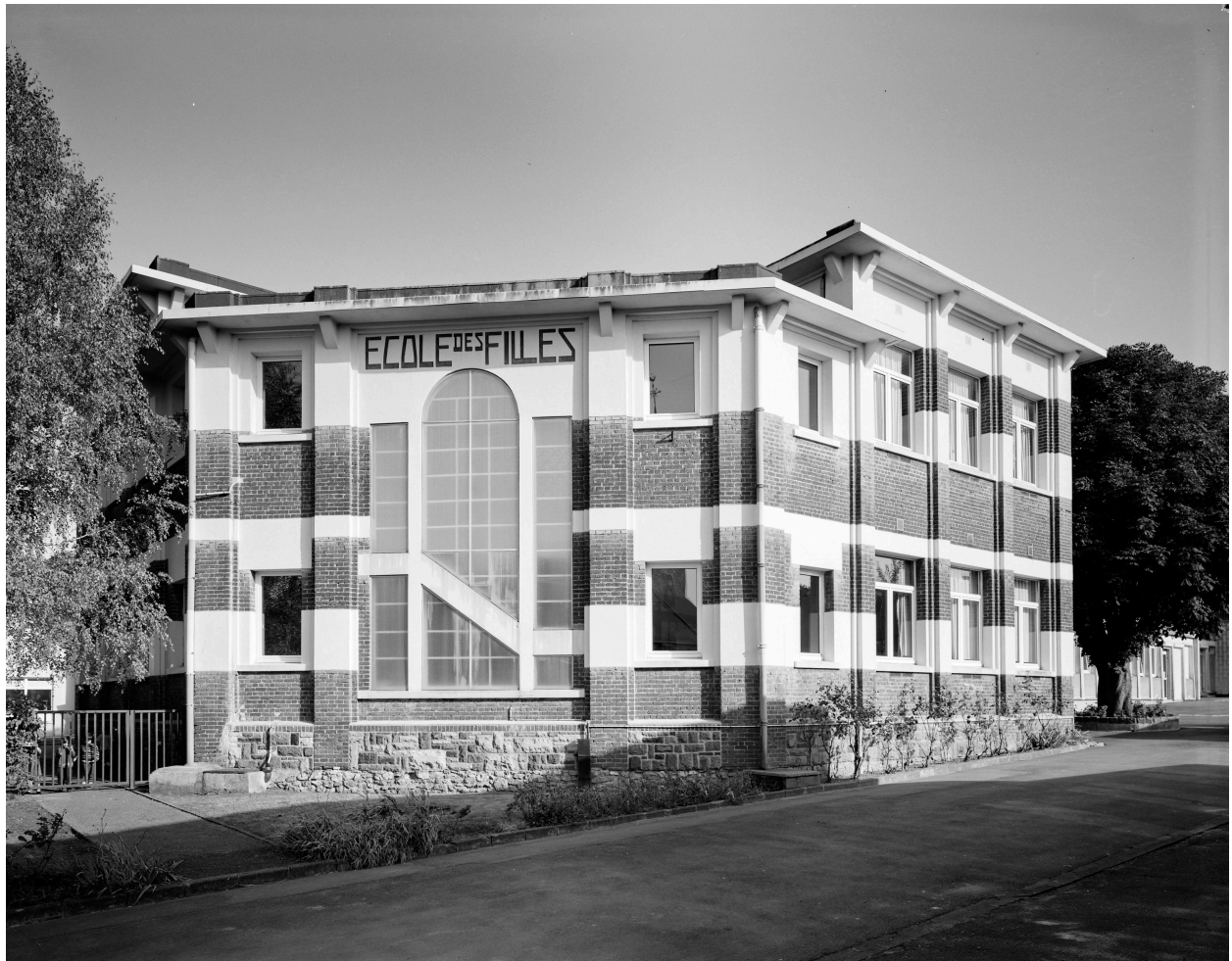
École de Marpent construite par l'architecte Adolphe Danis (1886-1969) en 1932.
