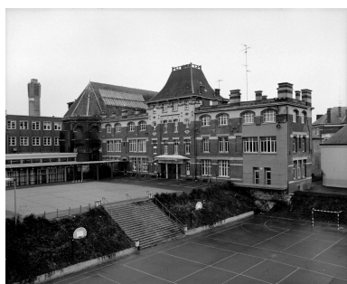
Ancien collège des Jésuites devenu collège Coutelle : aile reconstruite par l'architecte Jean Lafitte (1853-1928) en 1922. Phot. Thierry Petitberghien IVR31_20025900366X
