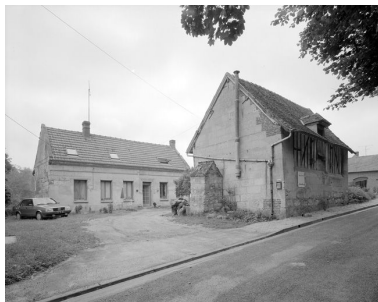
Vue générale. Phot. Jean-Michel Perrin IVR22_19856000809V
