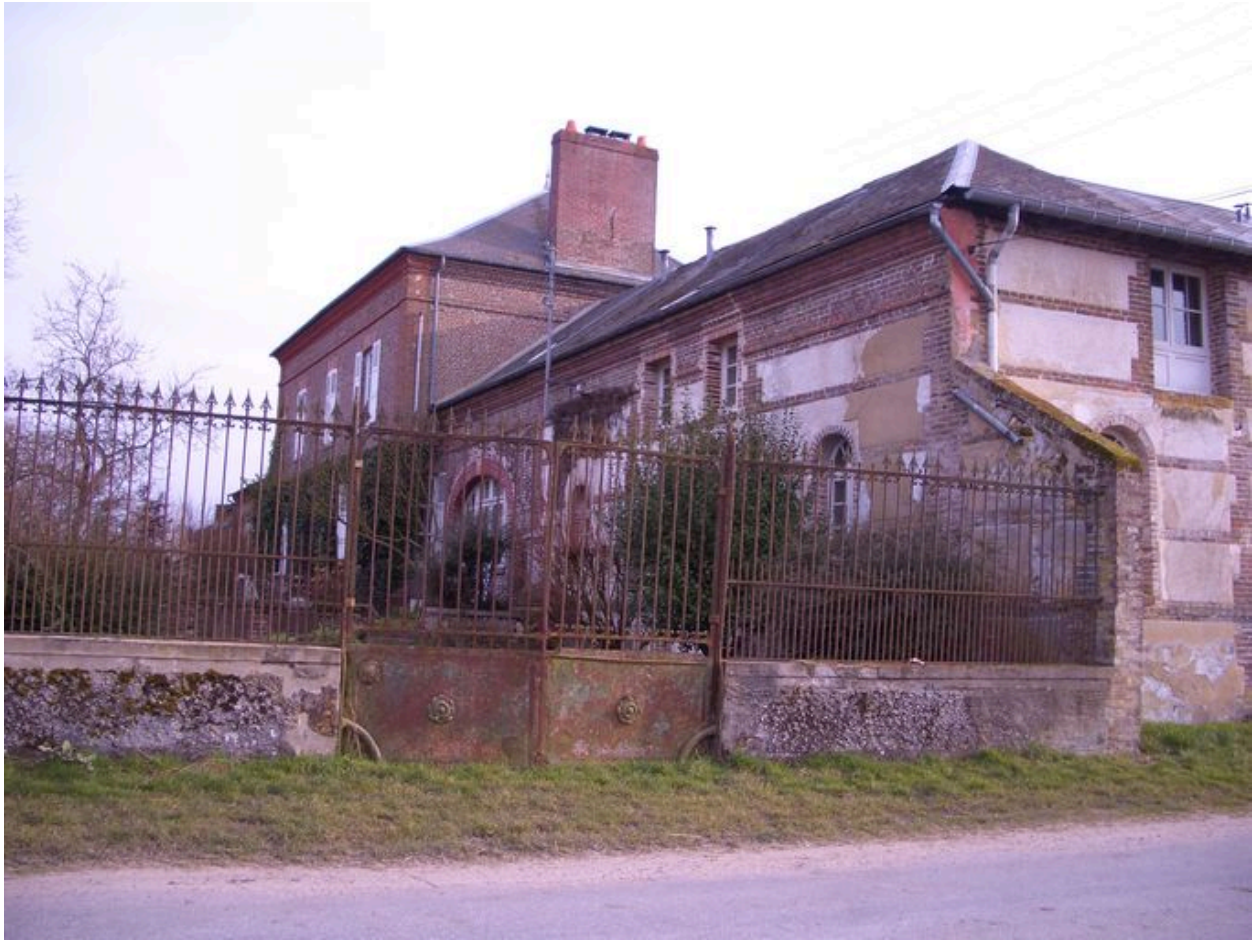
Vue postérieure du logis depuis la rue.
