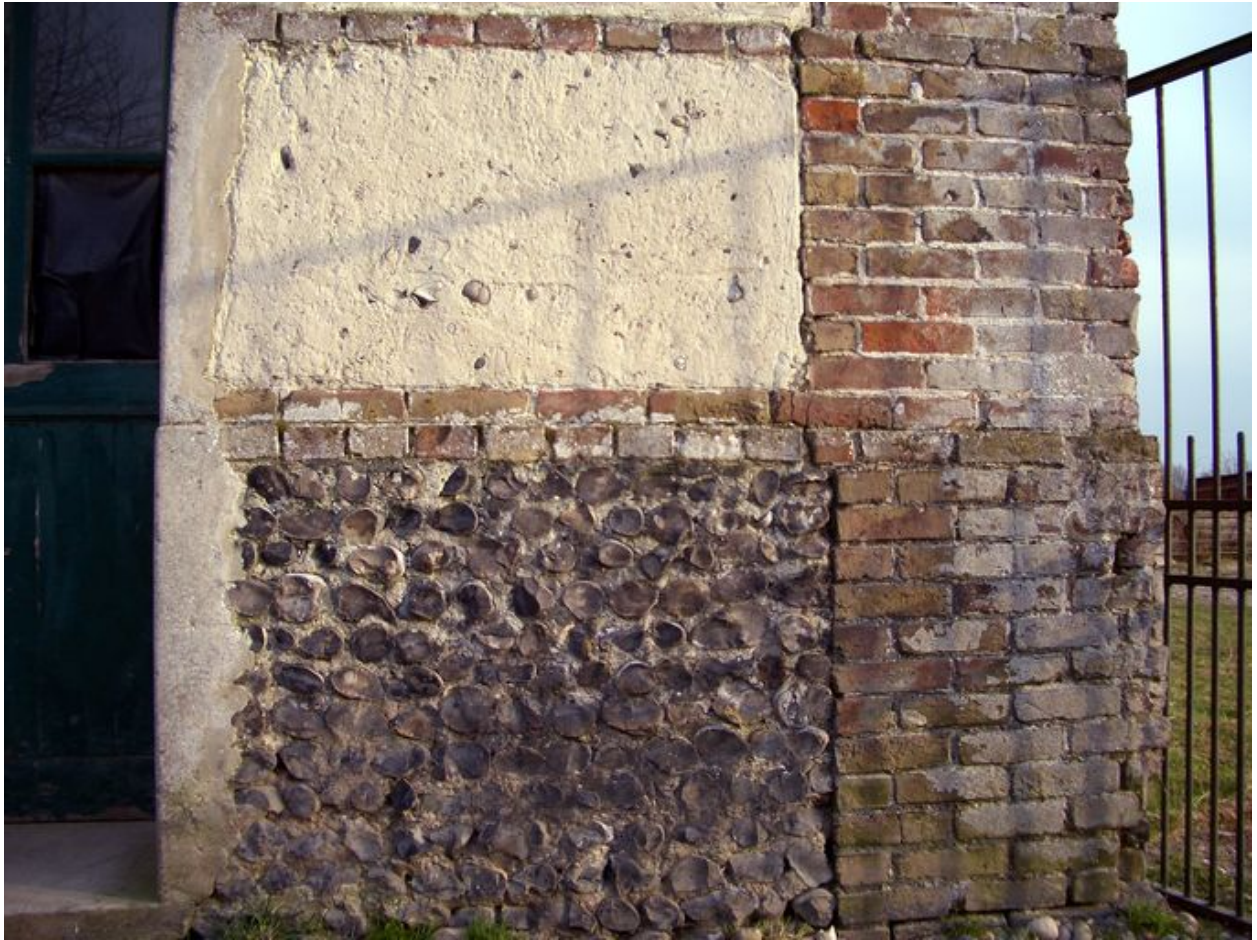
Détail de l'appareillage mixte des actuelles écuries.
