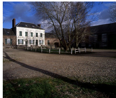
Vue générale du logis. Phot. Irwin Leullier IVR22_20078000049XA
