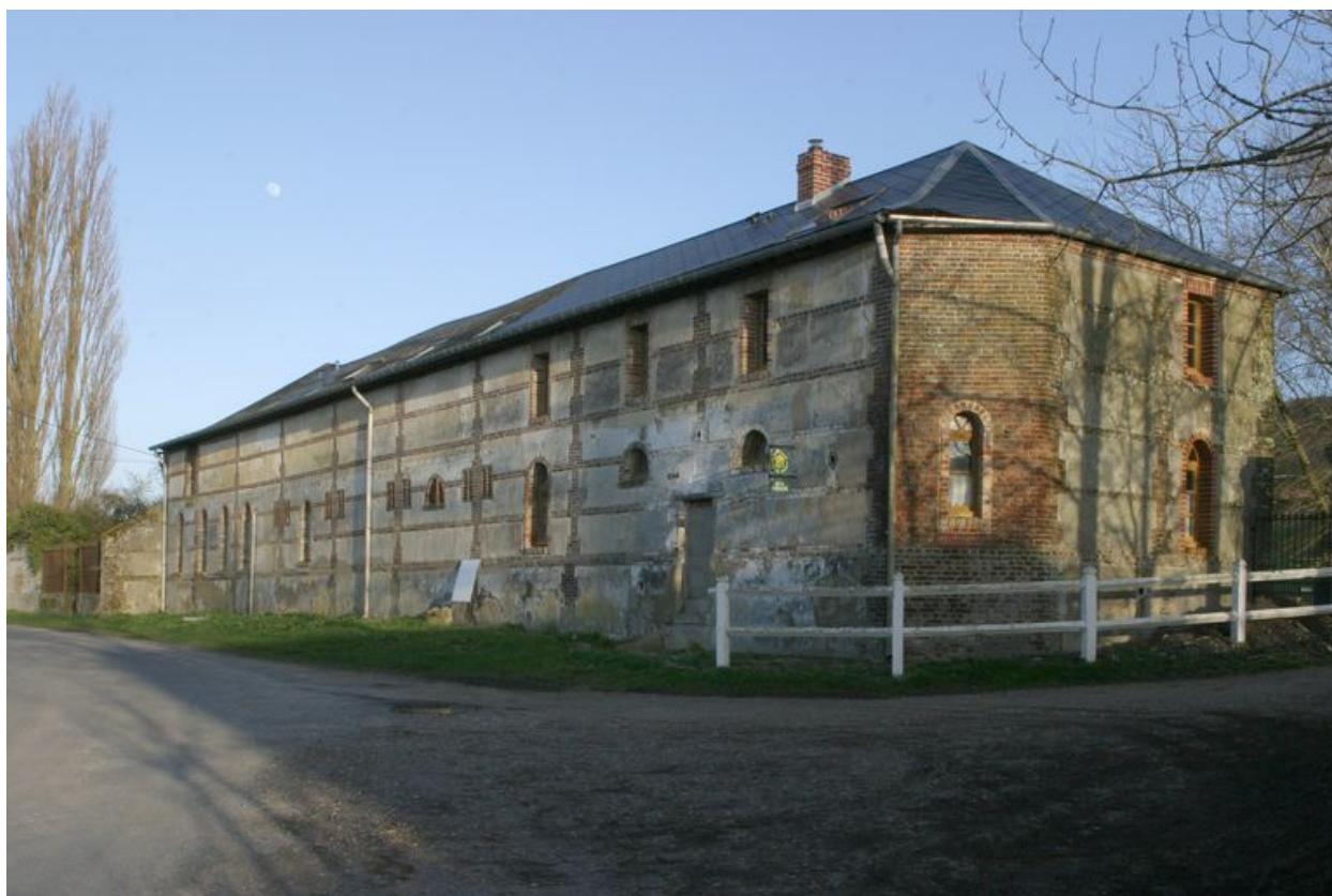
Vue des écuries sur rue.
