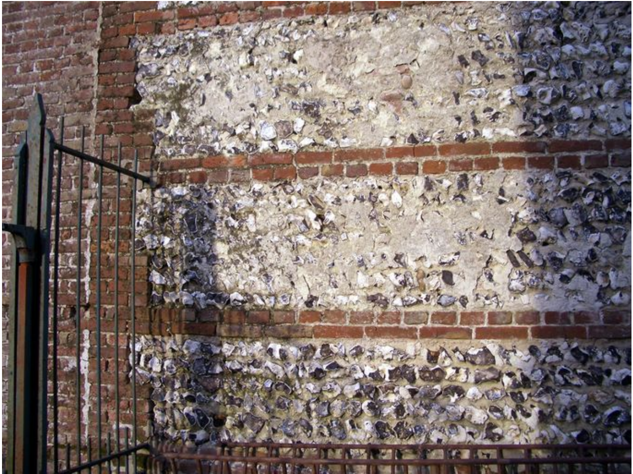
Détail de l'appareillage du pigeonnier.
