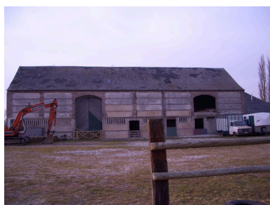
Vue postérieure des écuries. Phot. Inès Guérin IVR22_20058005107NUCA
