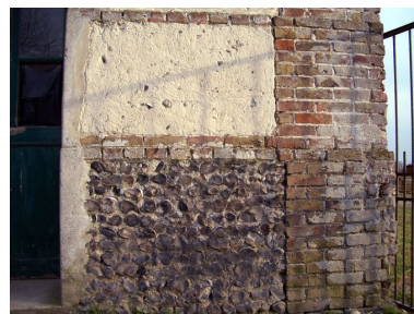
Détail de l'appareillage mixte des actuelles écuries. Phot. Inès Guérin IVR22_20058005105NUCA
