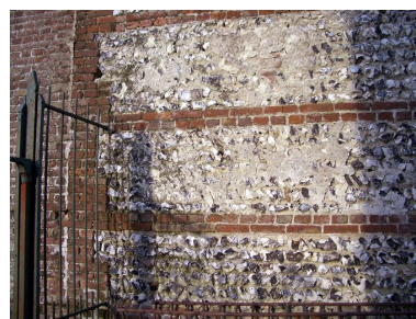
Détail de l'appareillage du pigeonnier. Phot. Inès Guérin IVR22_20058005115NUCA
