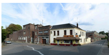
Ancienne usine de serrurerie Debeaurain, Grande-Rue. Phot. Thierry Lefébure IVR22_20148000522NUC2AQ
