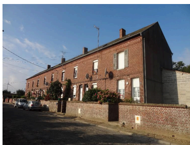
Ancienne cité ouvrière Debeaurain, rue de Méneslies.
