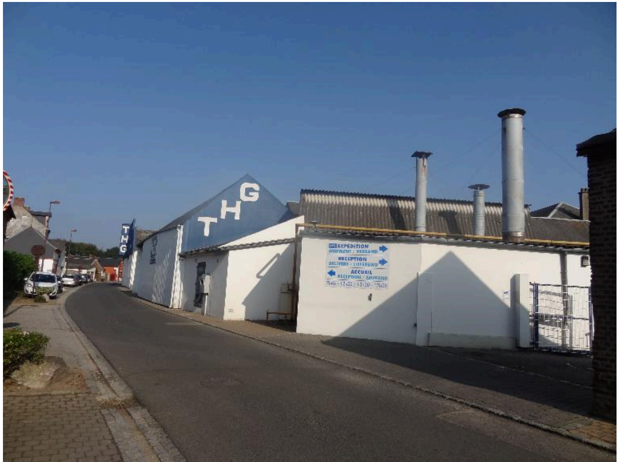
Usine de robinetterie THG, rue Tournière.
