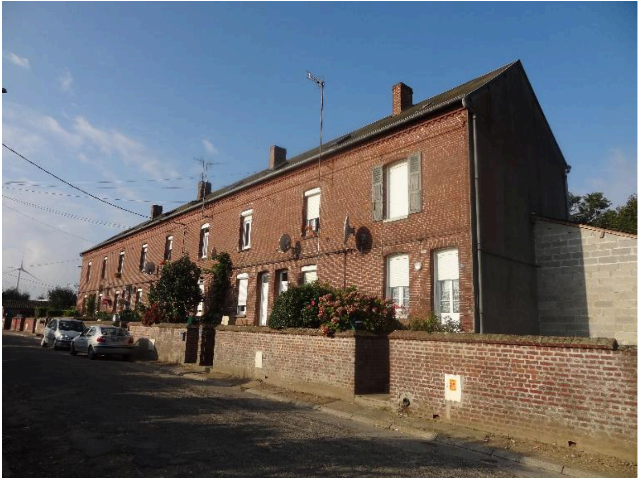
Ancienne cité ouvrière Debeaurain, rue de Méneslies.
