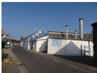
Usine de robinetterie THG, rue Tournière.
