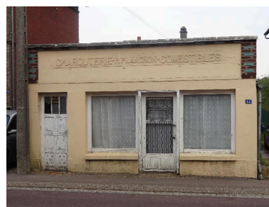
Ancienne boucherie, 14 rue d'Ault. Phot. Frédéric-Nicolas Kocourek IVR22_20158005059NUCA
