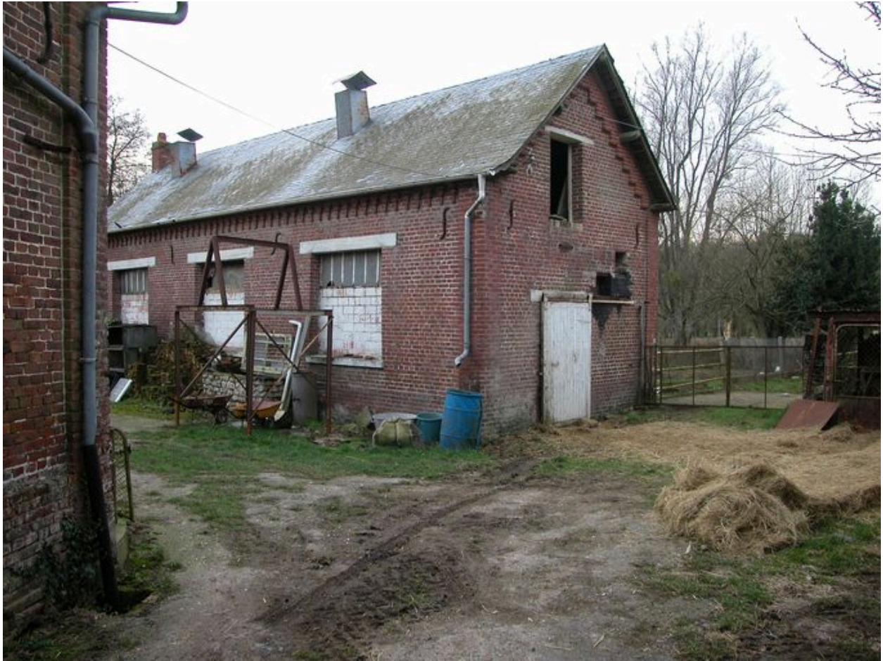
Atelier de montage, façade sur cour.
