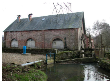
Vue d'ensemble du moulin et de sa roue hydraulique.
