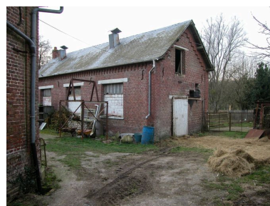
Atelier de montage, façade sur cour.
