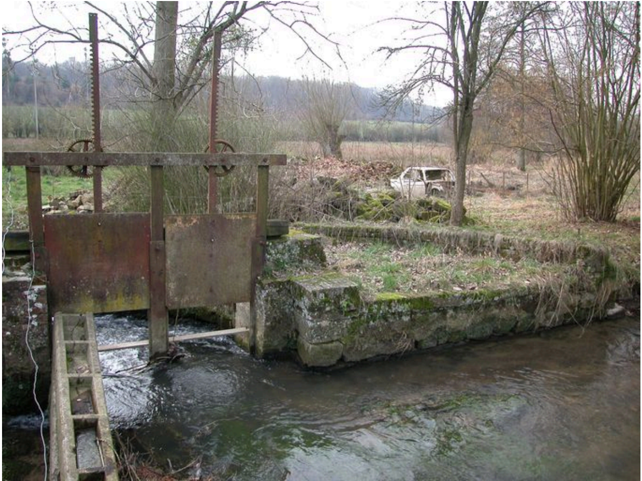
Détail du vannage de décharge et du déversoir maçonné.
