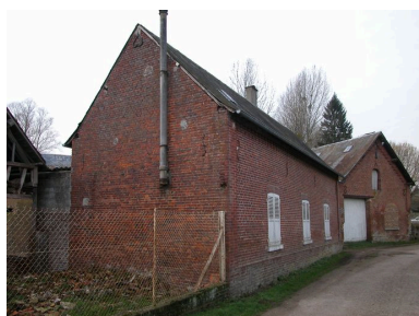
Vue d'ensemble du logement et du pignon du moulin, façade sur rue.
