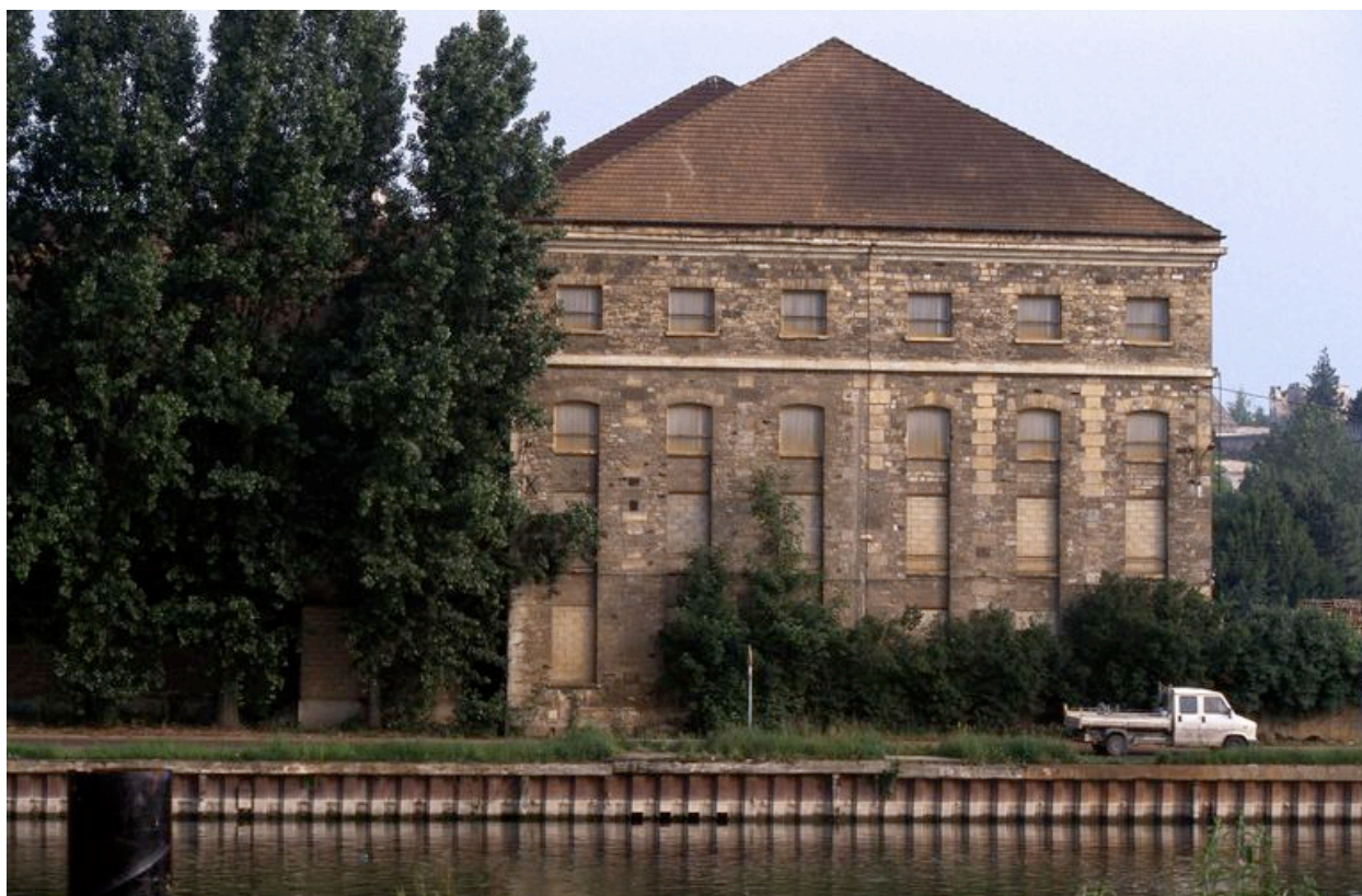
Façade de l'atelier de fabrication.
