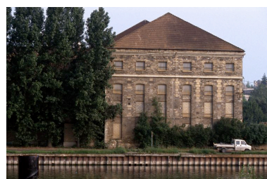
Façade de l'atelier de fabrication. Phot. Benoît Dufournier IVR22_19956000052ZA
