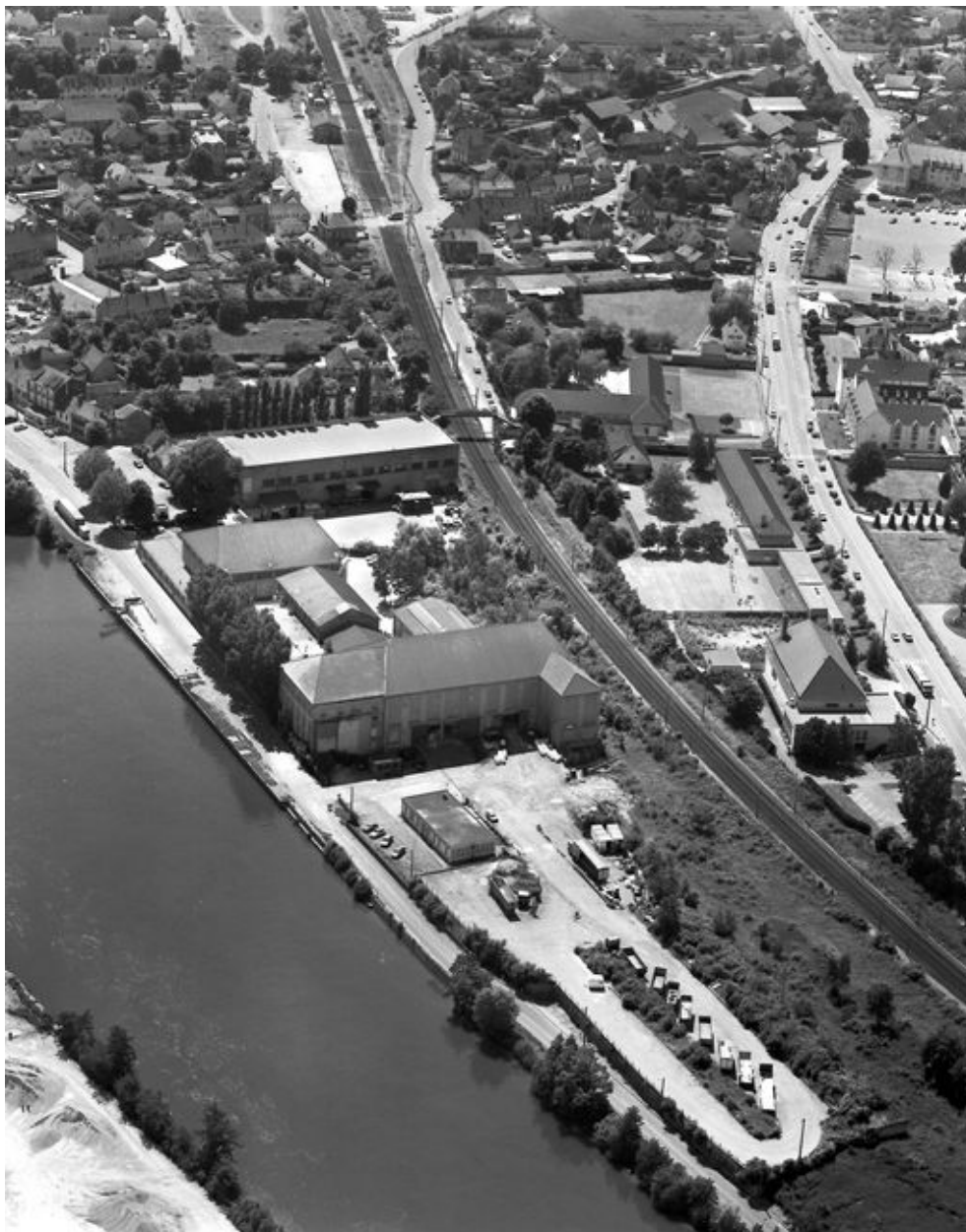
Vue aérienne vers le sud-ouest de la sucrerie, 1995 (Sanson Aviation).
