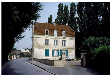
Logement d'ouvriers de la sucrerie. Phot. Thierry Lefébure IVR22_20106000774XA
