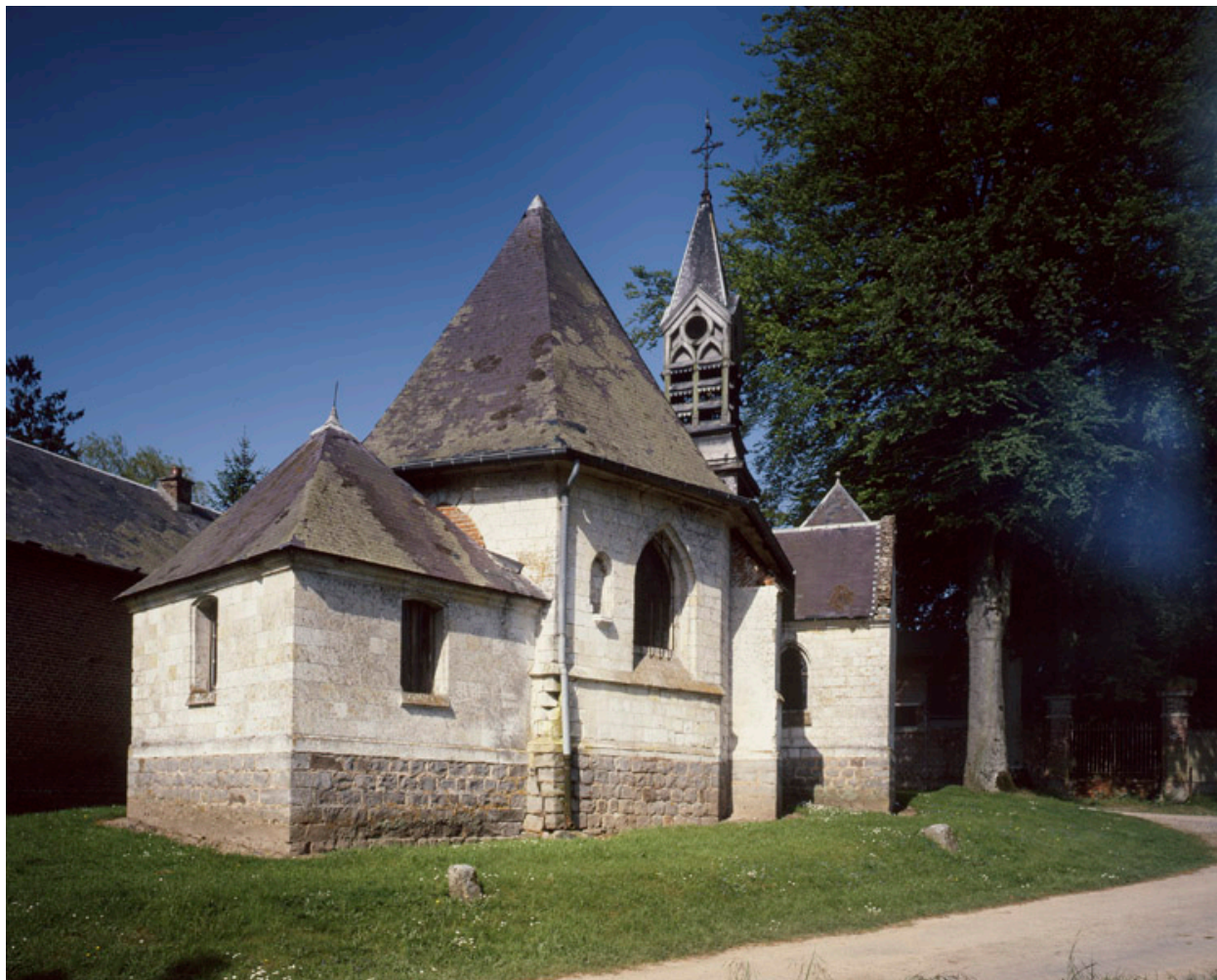
Montonvillers, église paroissiale Saint-Antoine.
