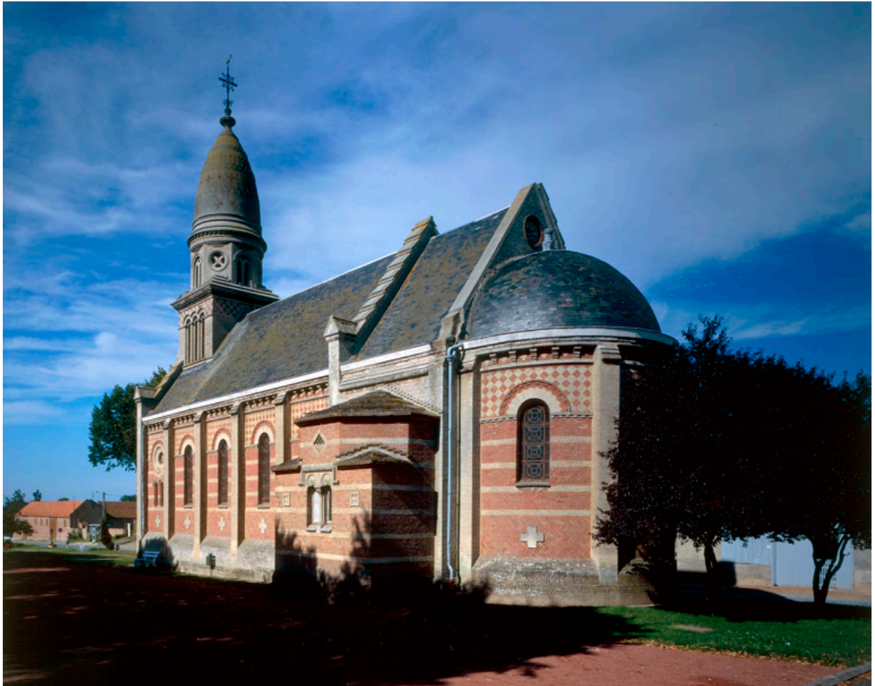
Cardonnette, église paroissiale Saint-Vaast.
