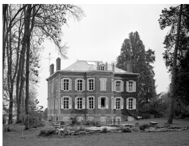
Façade postérieure. Phot. Thierry Lefébure IVR22_19978000262V
