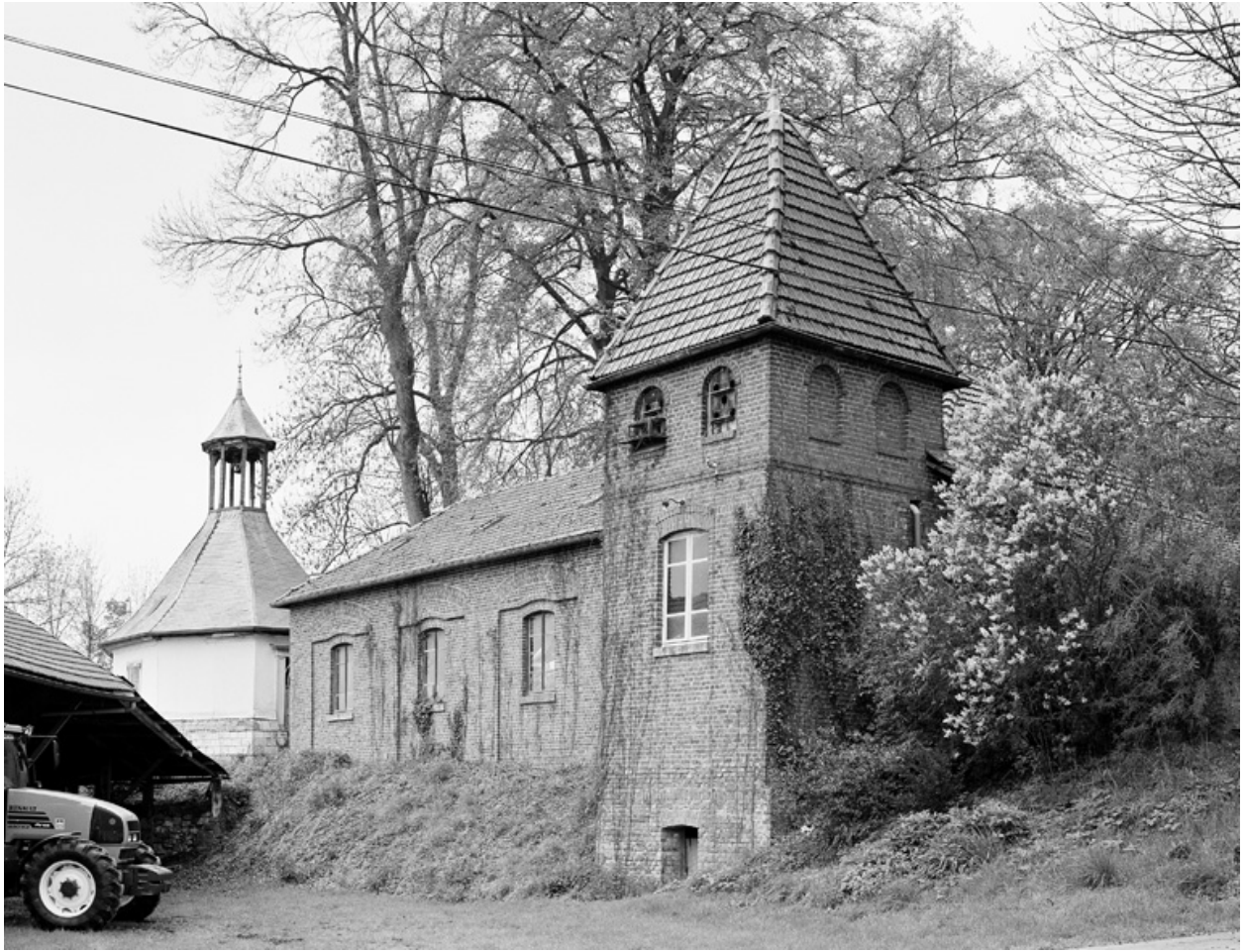
Etables au sud du château (1926).
