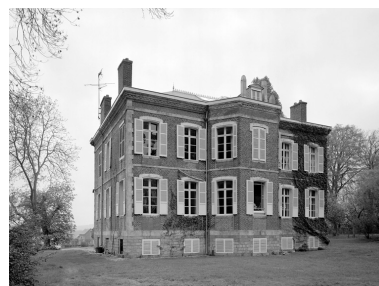
Façade postérieure, vue du nord-ouest. Phot. Thierry Lefébure IVR22_19978000263V
