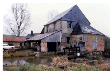
Vue d'ensemble du moulin, état en 1982. Phot. Jean-Pierre Blin IVR22_20036000427ZA
