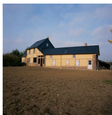
Façade est de l'atelier de fabrication et du logement attenant. Phot. Thierry Lefébure IVR22_20026001112XA
