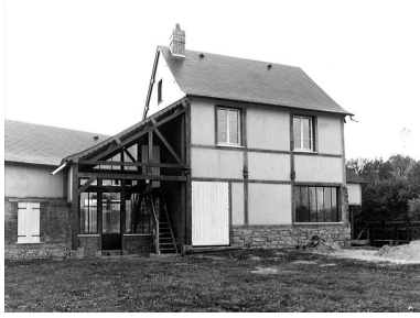
Façade ouest de l'atelier de fabrication. Phot. Thierry Lefébure IVR22_20026001086X
