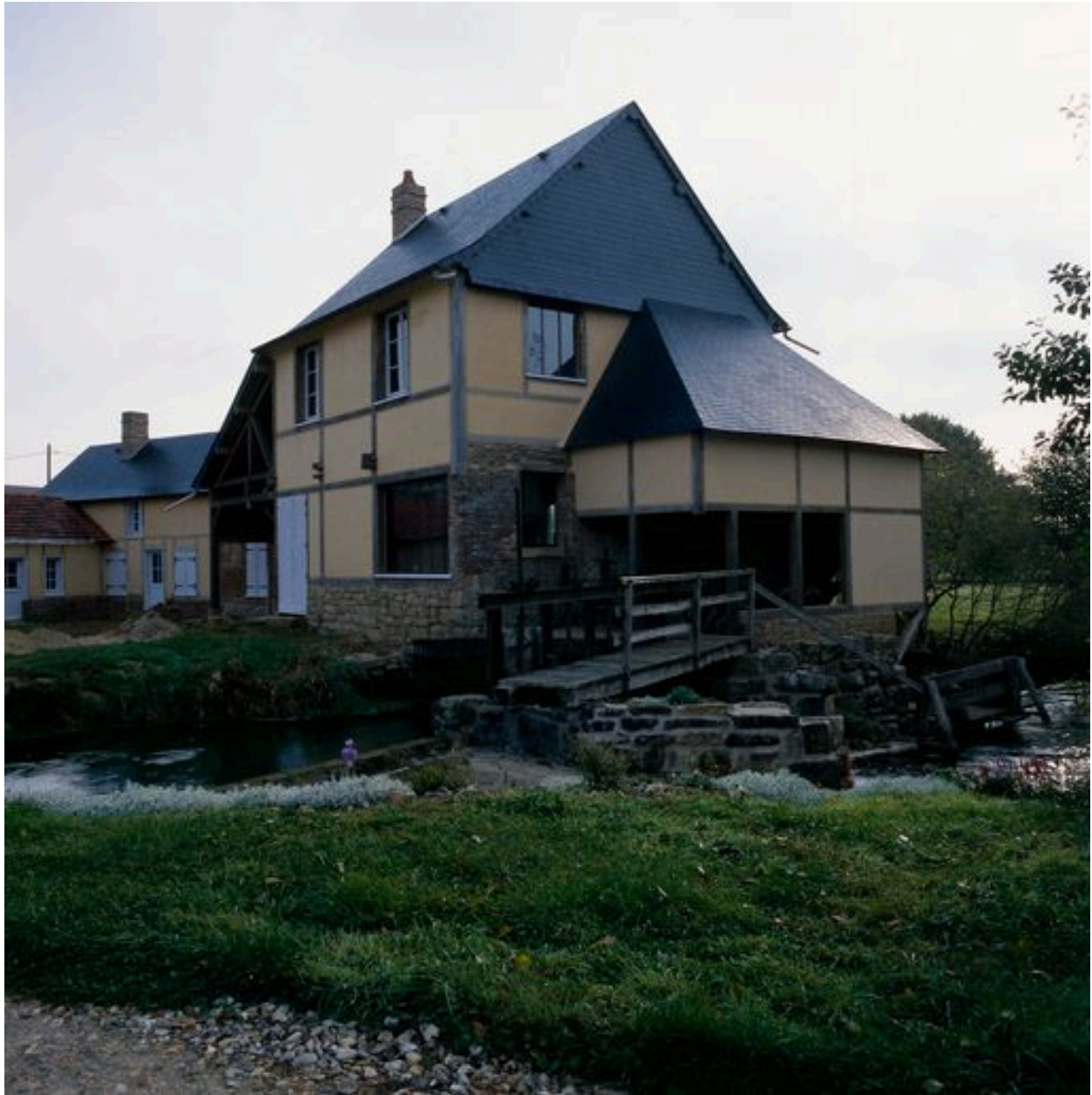
Atelier de fabrication et la cage abritant la roue hydraulique.
