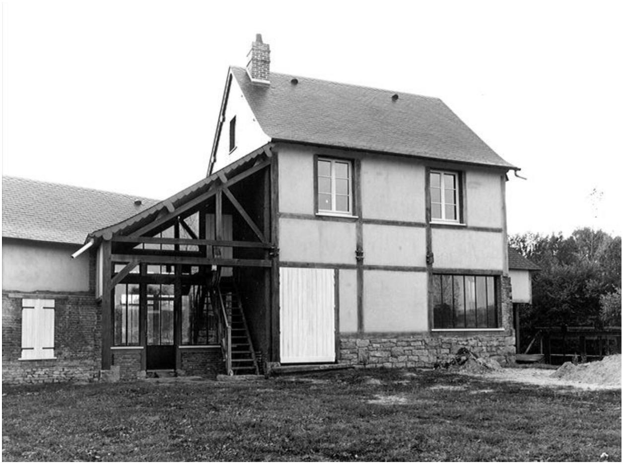
Façade ouest de l'atelier de fabrication.
