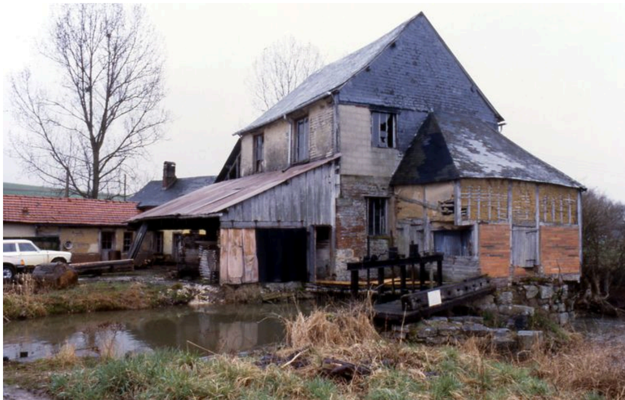
Vue d'ensemble du moulin, état en 1982.
