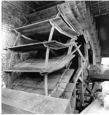
Détail de la roue hydraulique verticale. Phot. Thierry Lefébure IVR22_20026001064X
