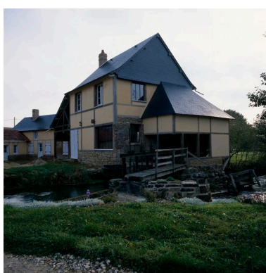
Atelier de fabrication et la cage abritant la roue hydraulique. Phot. Thierry Lefébure IVR22_20026001113XA
