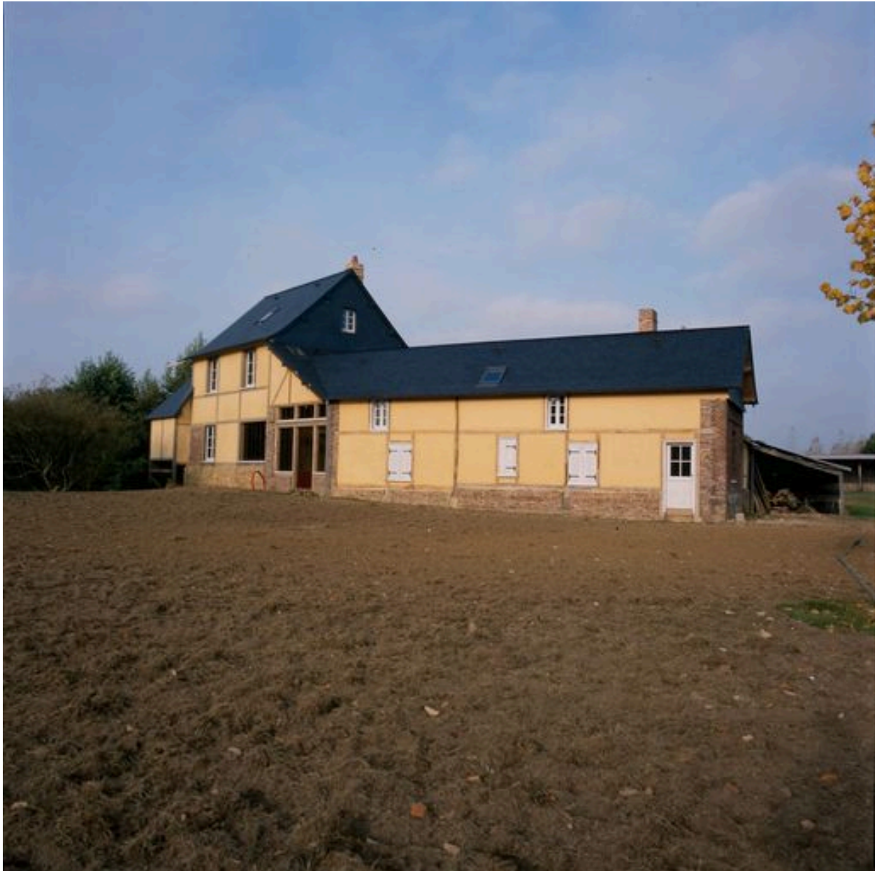
Façade est de l'atelier de fabrication et du logement attenant.
