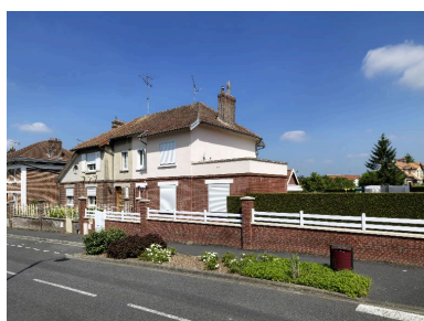
Maison d'employés à deux unités d'habitation. Type G. vue de trois-quarts (101-103 rue Paul-Doumer). Phot. Thierry Lefébure IVR32_20160200126NUC2A
