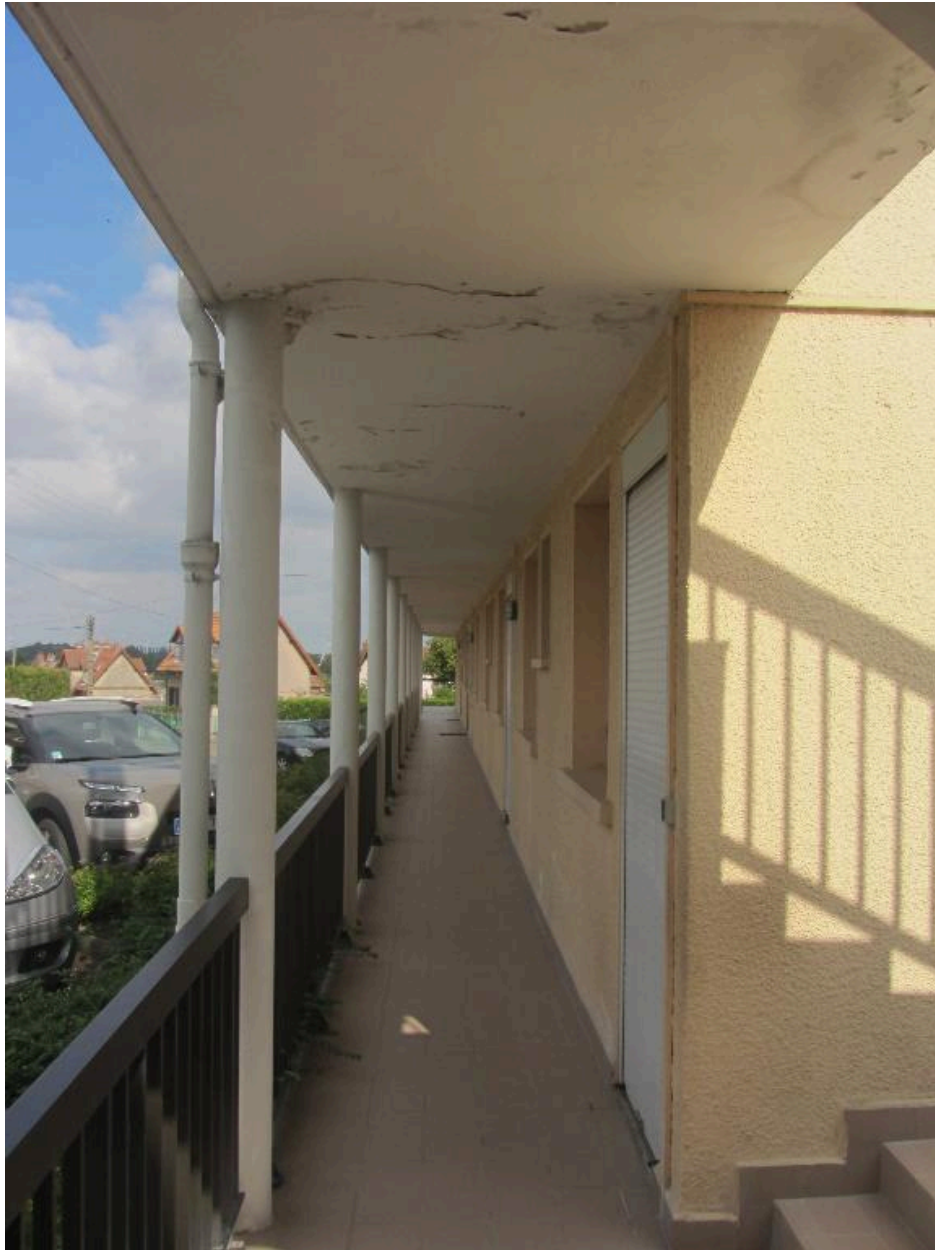
Immeuble des célibataires et des saisonniers de l'entreprise. Coursive desservant les appartements du rez-de-chaussée.
