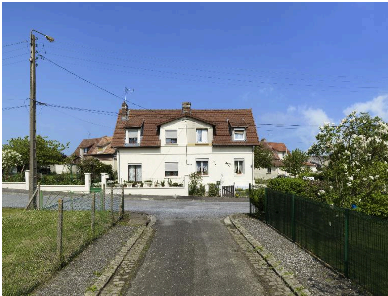
Maison de type A remaniée, vue de face (18 rue Pasteur).
