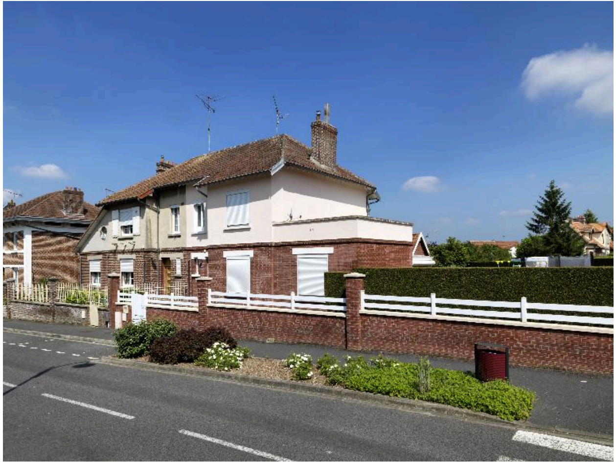
Maison d'employés à deux unités d'habitation. Type G. vue de trois-quarts (101-103 rue Paul-Doumer).
