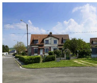
Maison de type A, vue de face (9-11 place Edmond-Roger). Phot. Thierry Lefébure IVR32_20160200044NUC2A
