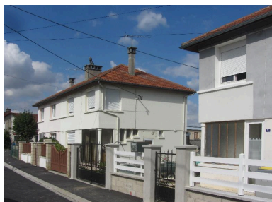
Maison à deux unités d'habitation (rue Alexandre-Dumas). Phot. Bertrand Fournier IVR32_20160205201NUCA
