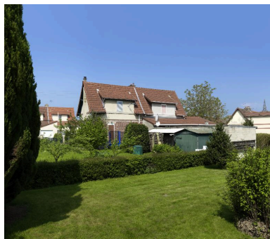
Maison de type C, vue générale de la façade arrière sur jardin (rue Pasteur). Phot. Thierry Lefébure IVR32_20160200050NUC2A
