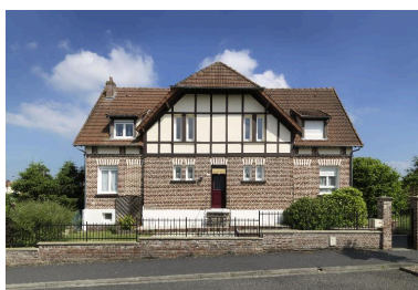
Maison d'employés à deux unités d'habitation, de type E, transformée en une seule habitation (125 rue Paul-Doumer). Phot. Thierry Lefébure IVR32_20160200133NUC2A
