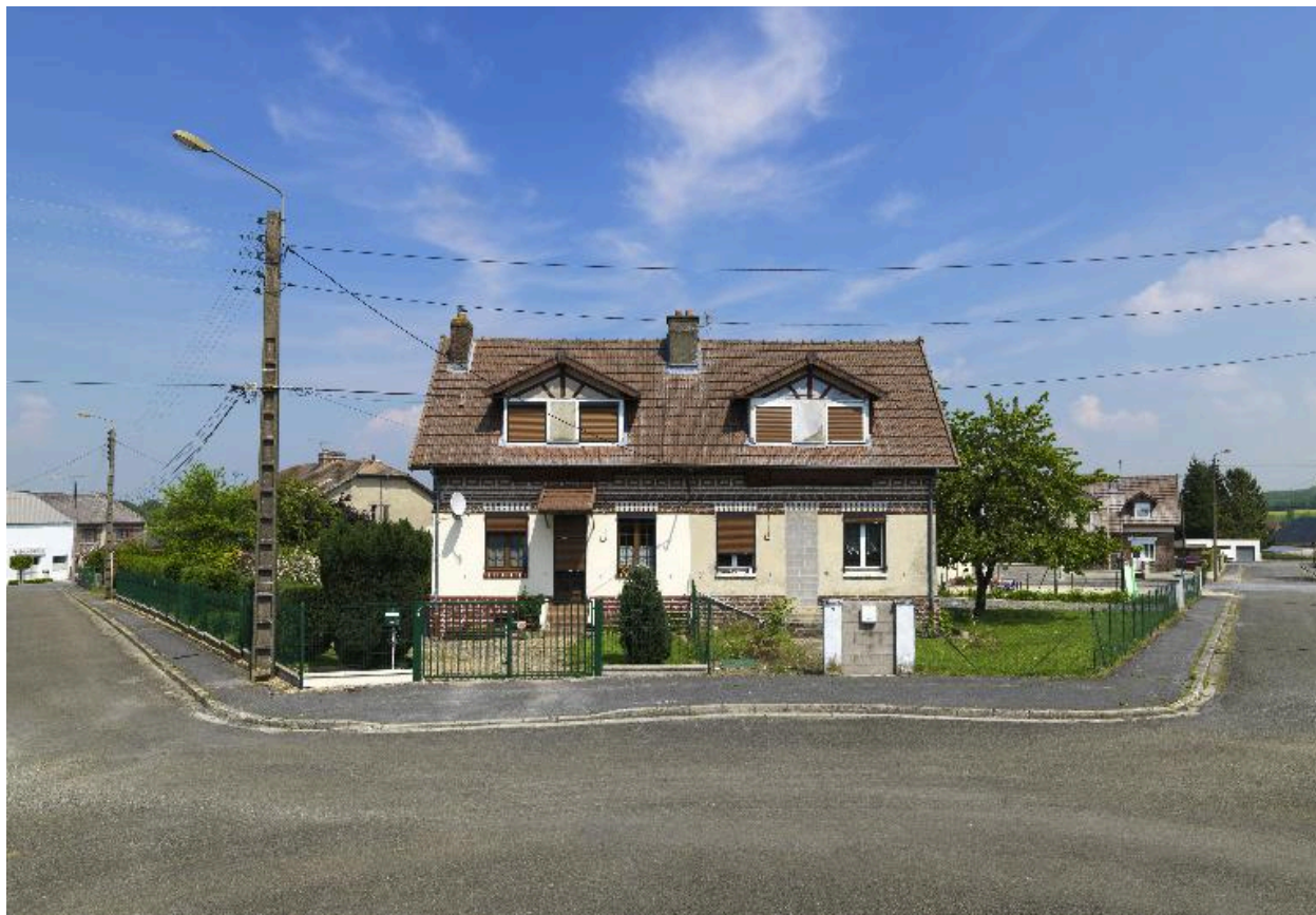
Maison de type C, façade sur rue (5-7 place Edmond-Roger).
