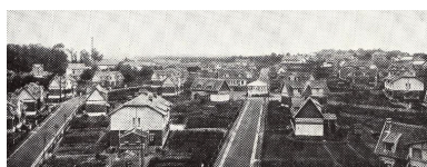
Vue d'ensemble de la cité Maguin, 1925. Phot. Maguin S.A. IVR32_20160205033NUCA
